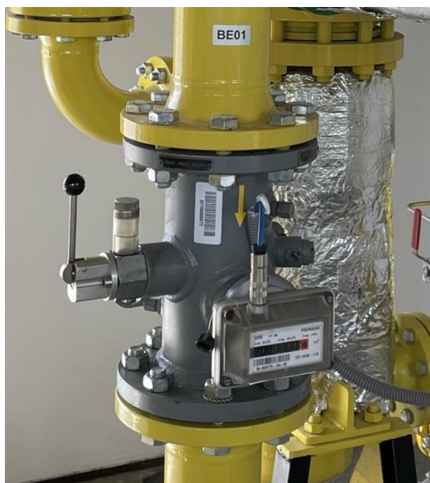
Obrázek 5.10 Hlavní plynoměr [archiv autora]
