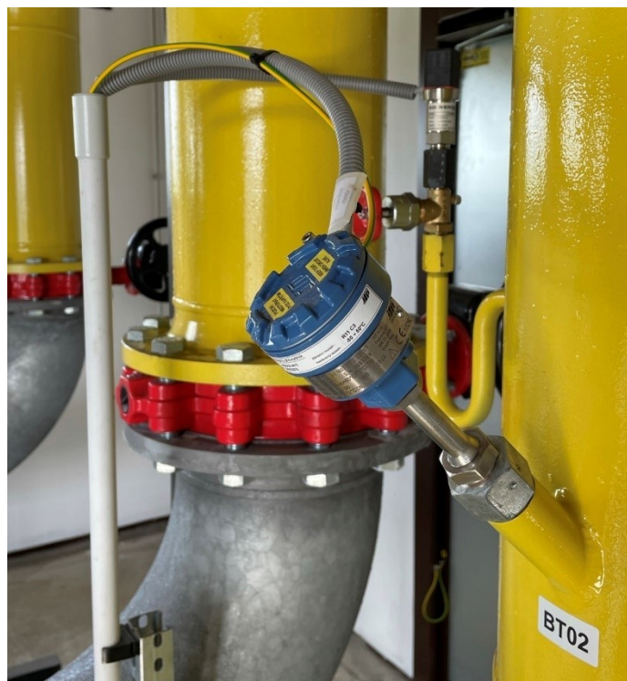
Obrázek 5.8 Snímač teploty plynu [archiv autora]
