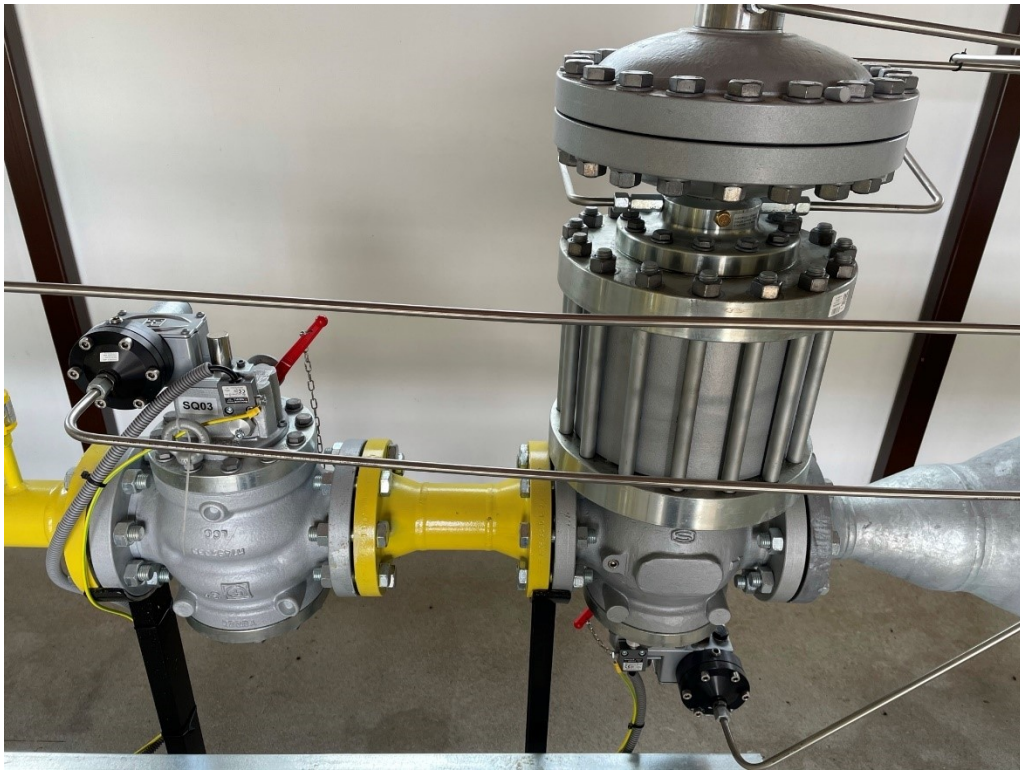
Obrázek 5.6 Bezpečnostní uzávěry včetně snímačů [archiv autora]
