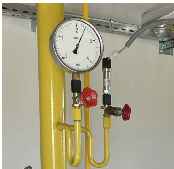
Obrázek 5.7 Snímač tlaku plynu [archiv autora]
