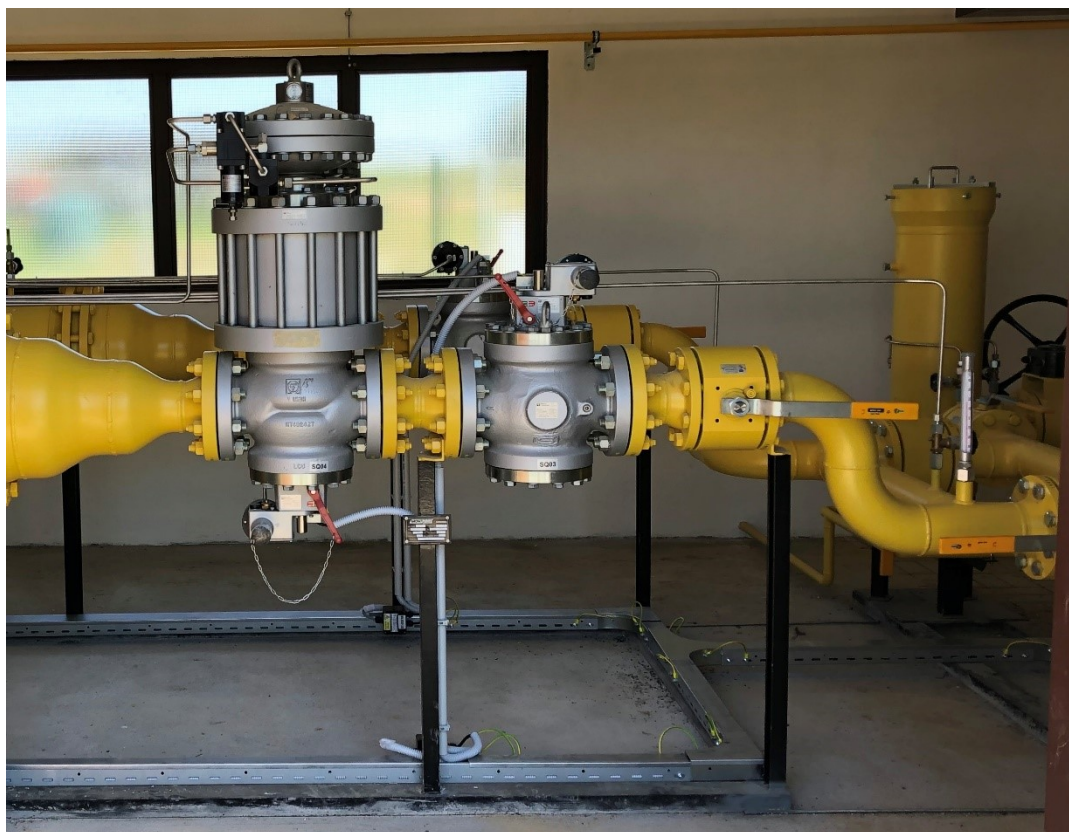
Obrázek 2.4 Jiný typ bezpečnostního uzávěru s regulátorem [archiv autora]
