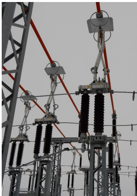
Obr. 3.6 – Pantografický odpojovač SX v zapnutém stavu
