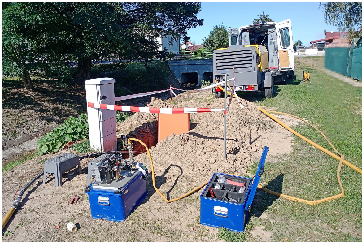
Obr. 1.1: Zafukování optického kabelu kompresorem
