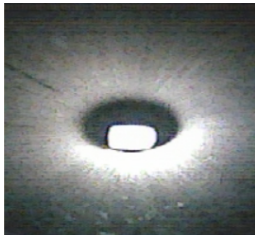
Obr. 12.6: Foto z trubky ucpané kamenem
