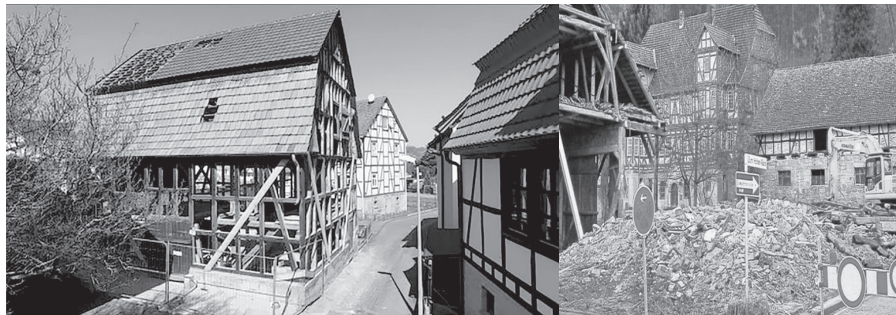
Obrázek 16-8 Wanfried. Sanace hrázděných domů
