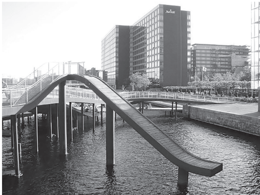
Obrázek 7-2 Kodaň. Kalvebod Bølge (Kalvebod Waves)
