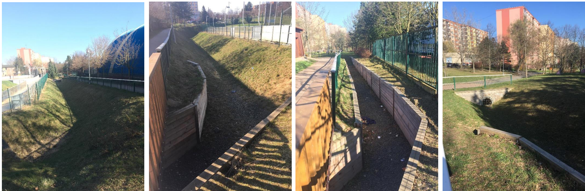
Svodný příkop na odvádění vody nacházející se podél Sport parku v Centrálním parku Lochotín, vlastní foto z dubna 2021
