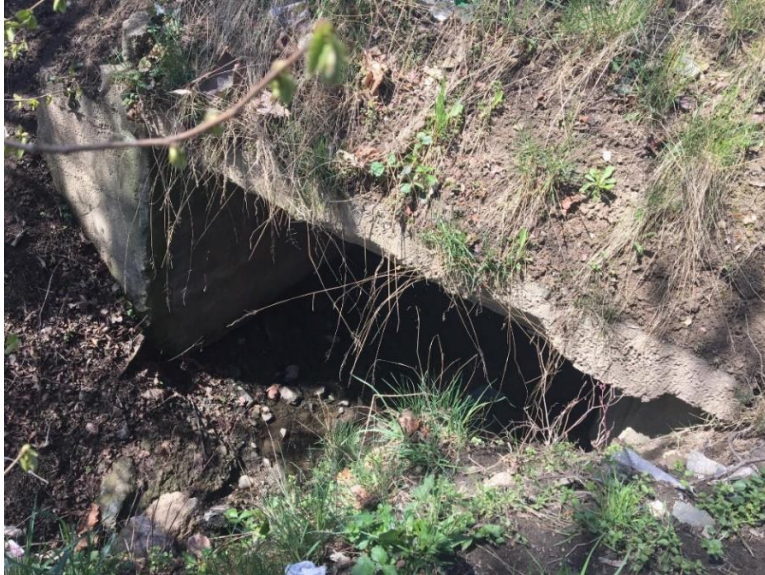
Propustek výústní stoky, vlastní foto z dubna 2021
