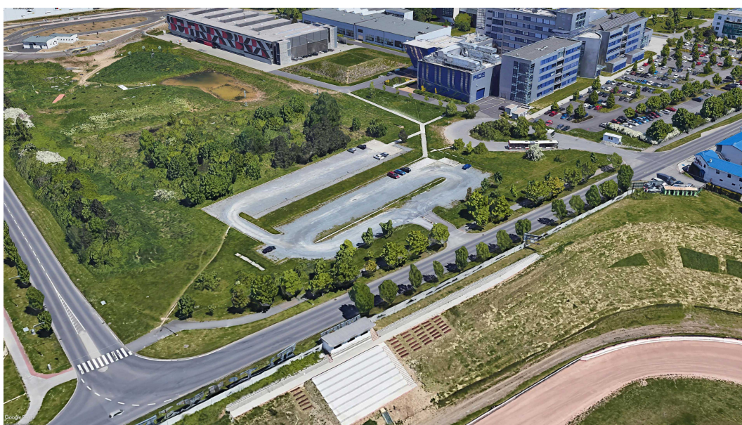
Obr. 7.2: Pohled na parkoviště u budovy RICE (převzato z Google Earth).
