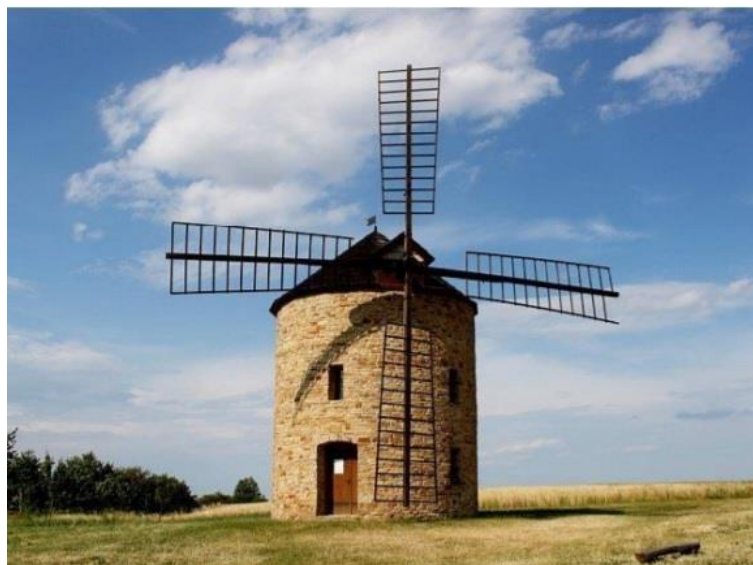
Obr.14 Větrný mlýn pracující na odporovém principu [3]
