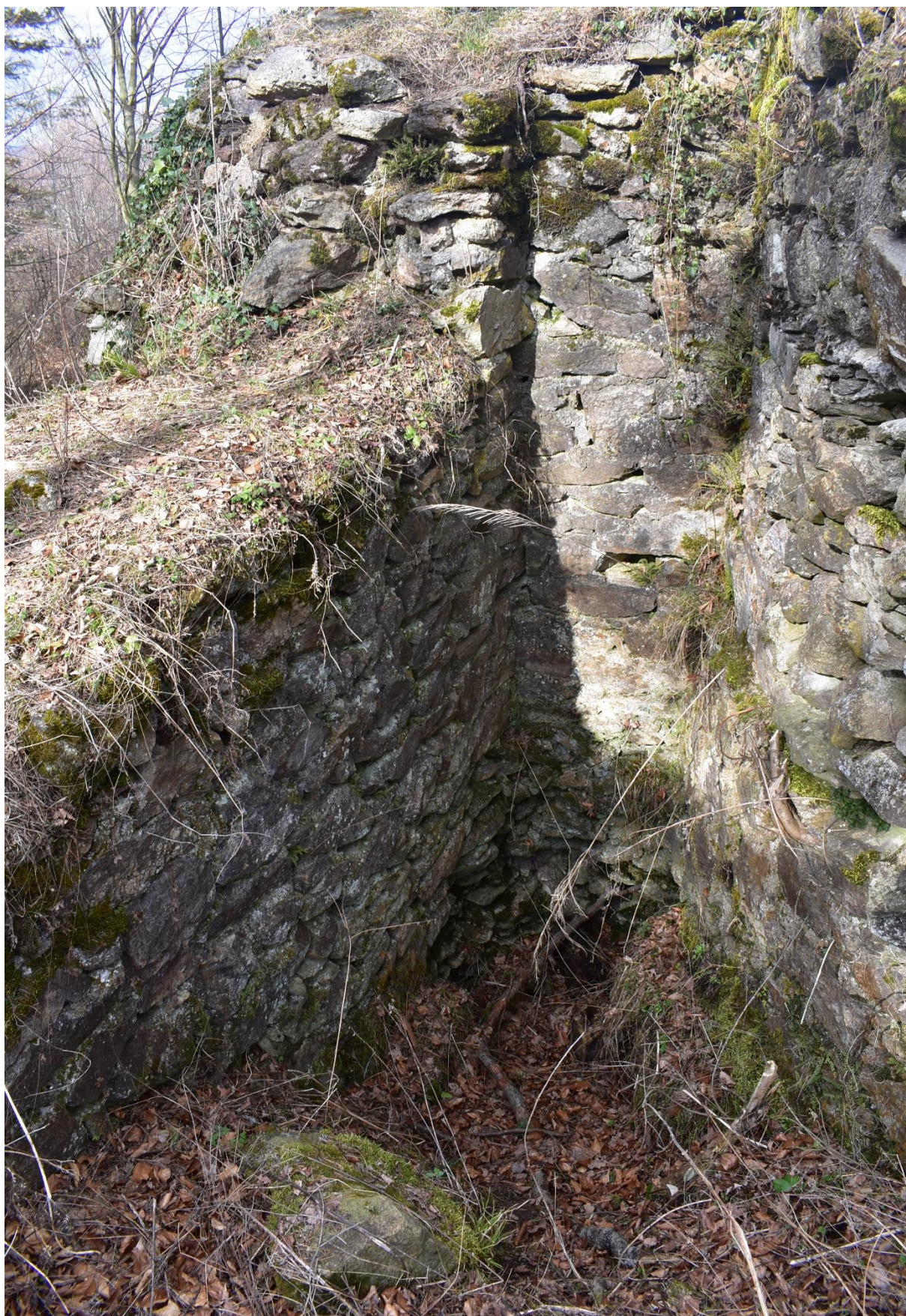
Obr. 23. Hrad Osule. Odhalená část zdivu u severního bergfritu (rok 2019). Foto autor.
