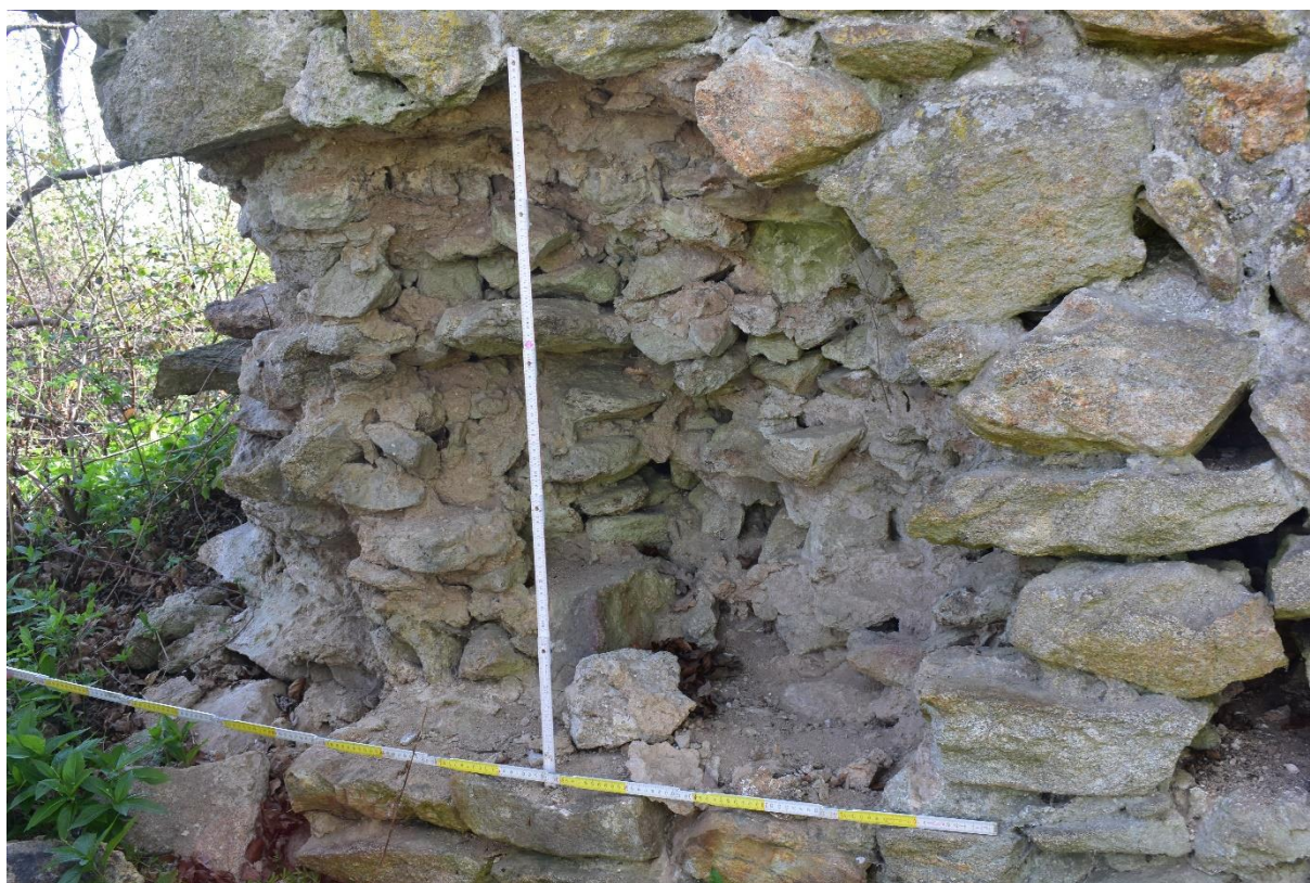
Obr. 31. Hrad Osule. Vylámané zdivo u paty čelního palácového křídla na východní straně (rok 2020). Foto autor.
