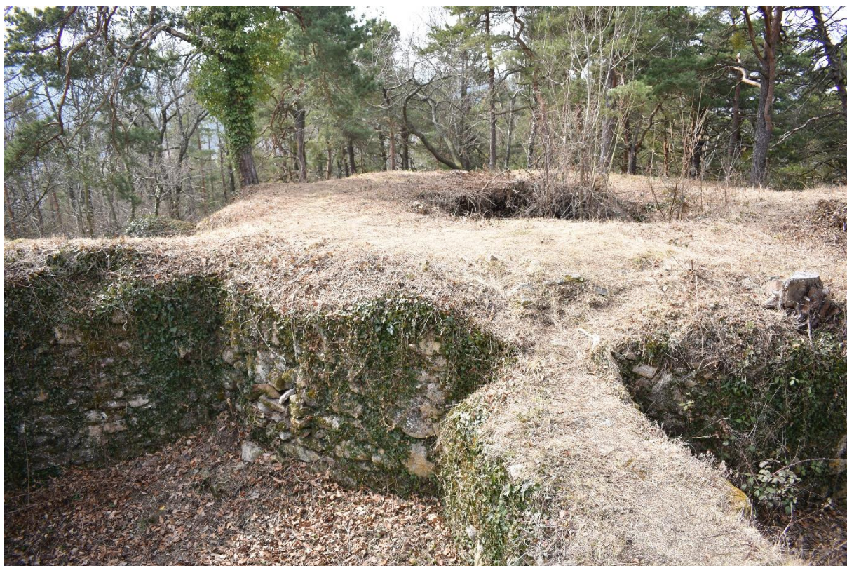
Obr. 37. Hrad Osule. Pohled na jižní bergfrit ze severu (rok 2022). Foto autor.
