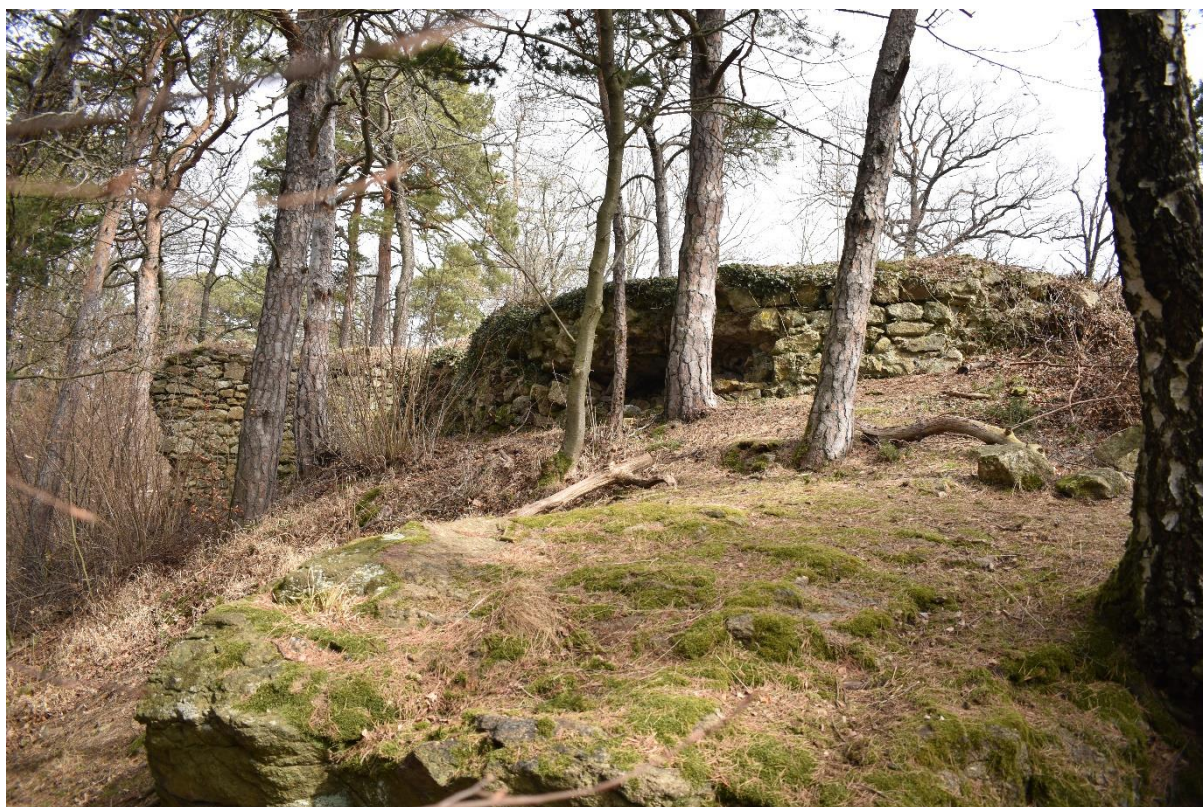
Obr. 42. Hrad Osule. Celkový pohled na jižní bergfrit od jihu (rok 2022). Foto autor.
