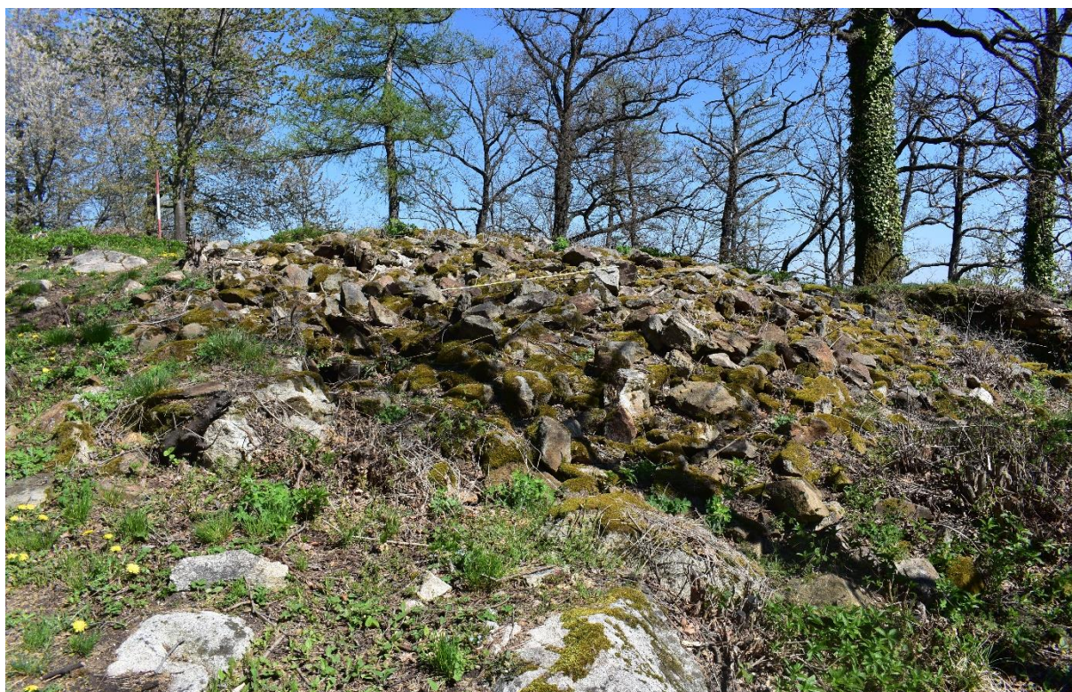
Obr. 36. Hrad Osule. Nahromaděný stavební materiál ve středu nádvoří palácové části (rok 2020). Foto autor.
