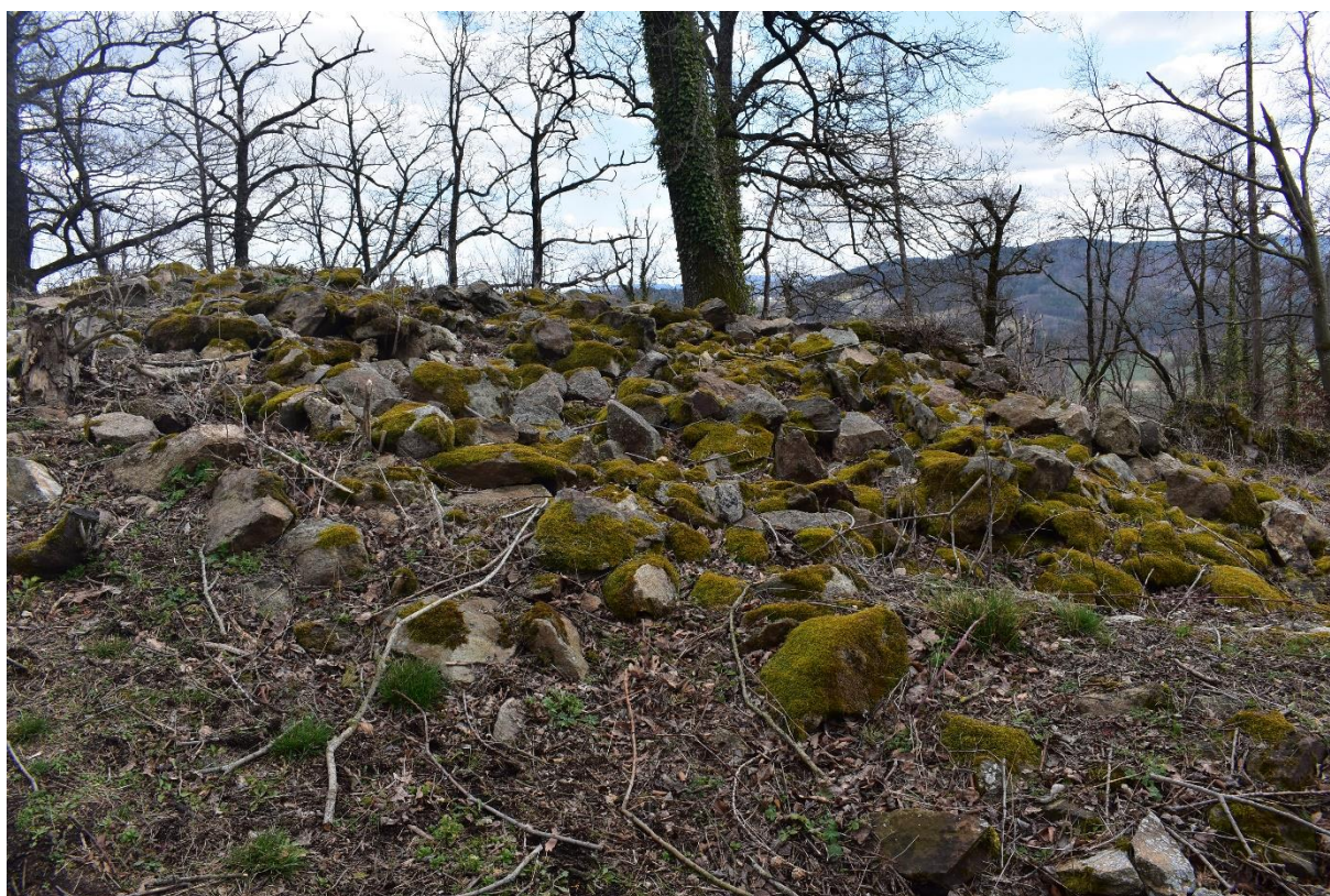
Obr. 35. Hrad Osule. Nahromaděný stavební materiál ve středu nádvoří palácové části (rok 2019). Foto autor.
