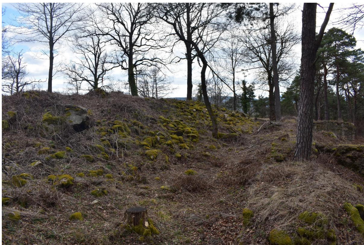
Obr. 34. Hrad Osule. Nádvořní část se skalním hřebenem (rok 2020). Foto autor.
