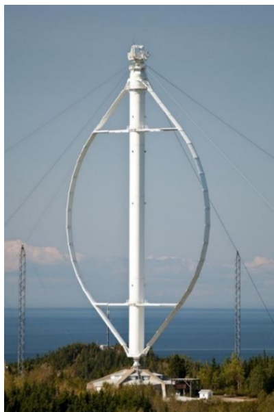
Obr. 3.6 Největší Darrieova turbína Éole (3,8 MW) – Cap-Chat, Quebec, Canada 24 [66]
