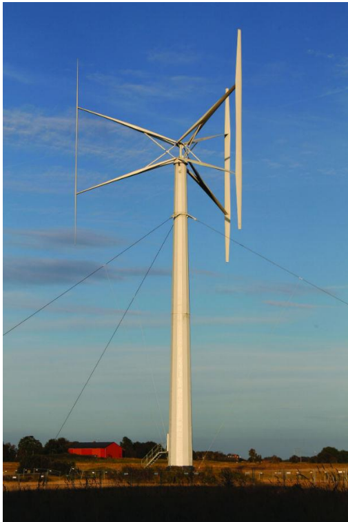
Obr. 3.9 T1 – turbína (200 kW), Falkenberg (Švédsko) [65]
