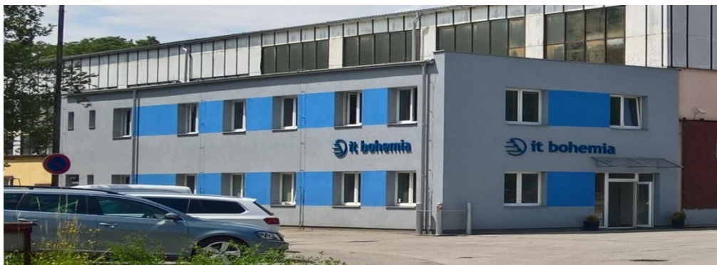
Obr. 4.: Sídlo společnosti v Plzni
