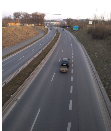
(b) Snímek před odstraněním objektů v popředí
