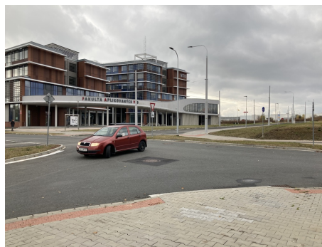
(b) Snímek před odstraněním objektů v popředí
