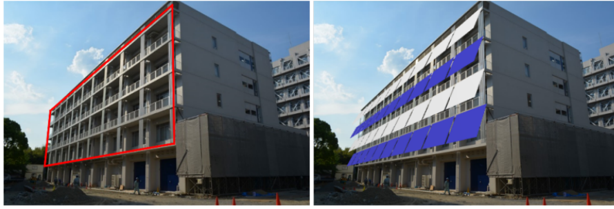
Obrázek 14: Ukázka promítnutí virtuálních markýz na reálné budově
