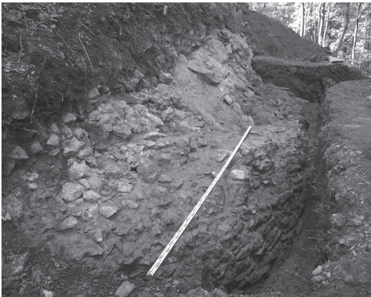
Obr. 14. Sonda 2 na svahové kupě nad Levínem (okr. Litoměřice). Pohled oblouku zdi směrem k bráně. Foto L. Kursová. – Abb. 14. Sonde 2 an der Abhangkuppe über Lewin. Blick vom Bogen der Mauer in Richtung Tor. Fotografie L. Kursová.
