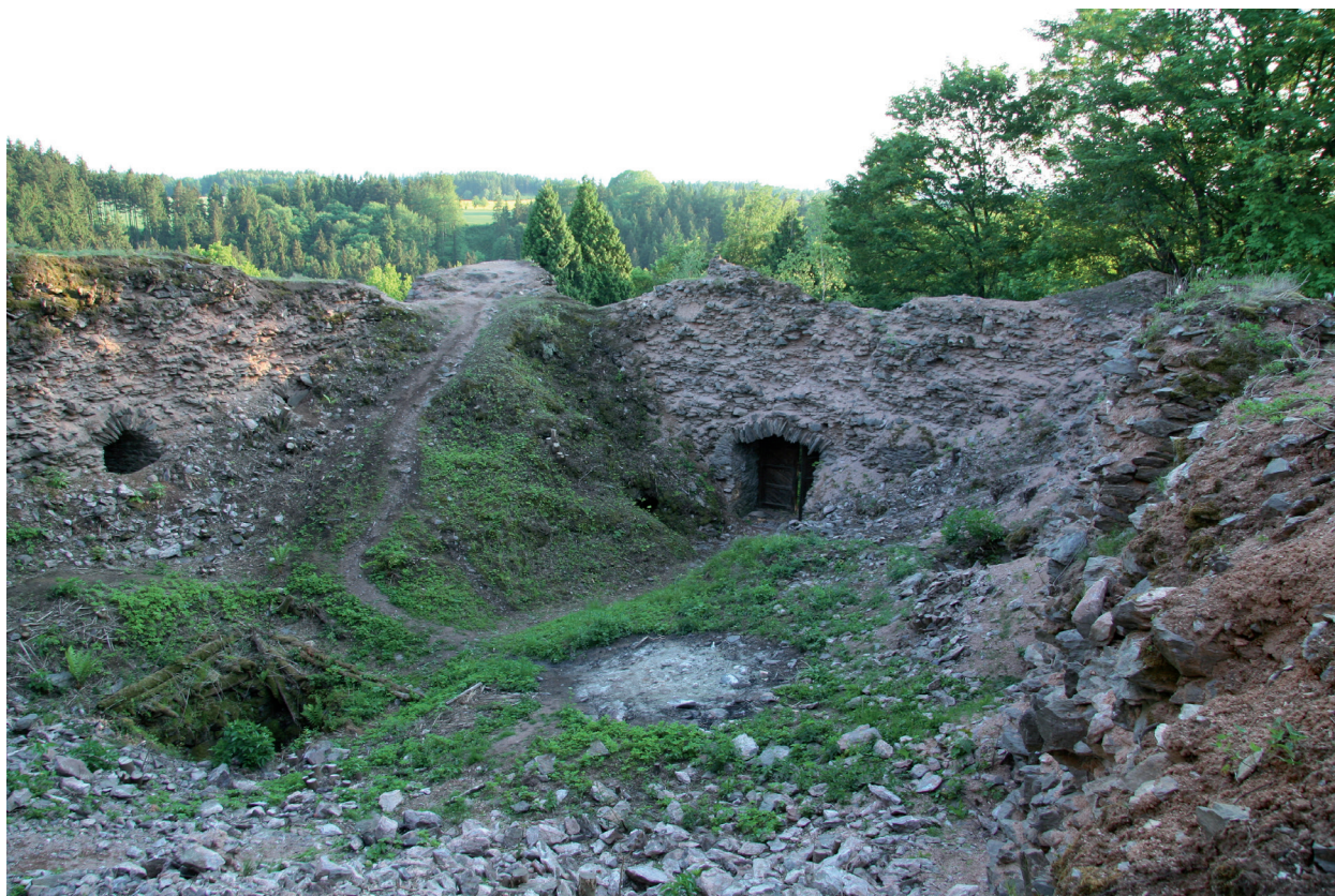
Obr. 10. Hradní nádvoří po odstranění náletů v roce 2008. Foto P. Nožička 2008. – Abb. 10. Der Burghof nach der Entfernung des Gehölzes im Jahre 2008. Fotografie P. Nožička 2008.
