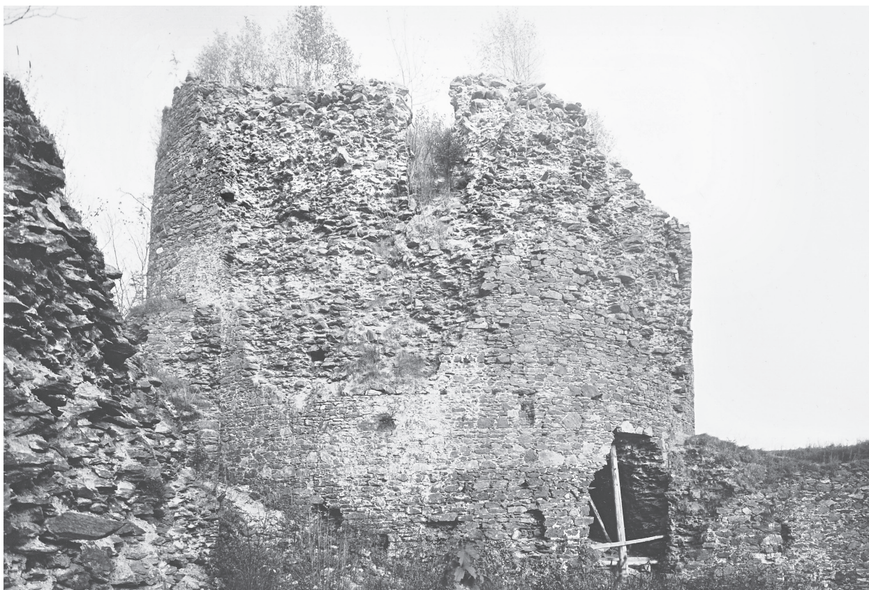
Obr. 6. Velká věž, pohled od severní hradby. Stavebně historický průzkum hradu 1977. NPÚ ÚOP v Josefově, plánová dokumentace, Frymburk F-6. – Abb. 6. Der große Turm, Blick von der Nordmauer. Baugeschichtliche Untersuchung der Burg 1977. NPÚ ÚOP in Josefstadt, Plandokumentation, Frymburk F-6.
