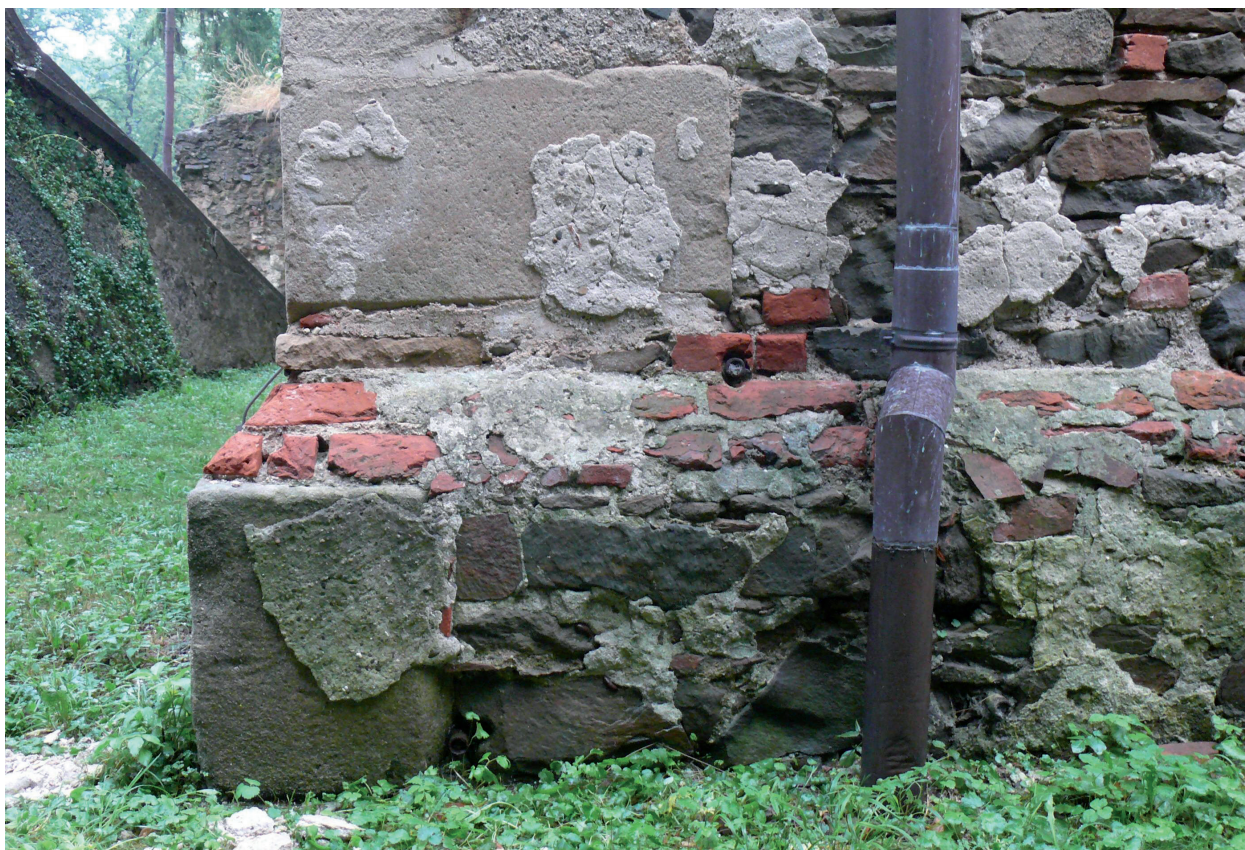
Obr. 9. Detail východního nároží zámku, nad soklem druhotně použitý okosené pískovcové ostění s kamenickou značkou. Foto J. Slavík 2015. – Abb. 9. Detail der Ostecke des Schlosses, über dem Sockel, die sekundär benutzte Sandsteinwand mit dem Steinmetzzeichen (Fotografie J. Slavík 2005).
