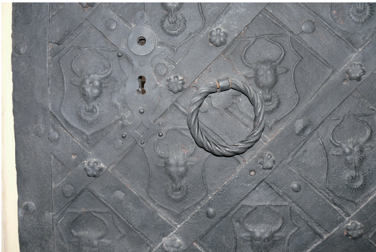
Obr. 6. Detail zámkové partie dveří s přitažným kruhem a klasicistním štítkem zámku a kliky. – Abb. 6. Detail der Schlosspartie der Tür mit dem kreisförmigen Griff und dem klassizistischen Wappen des Schlosses und der Klinke.
