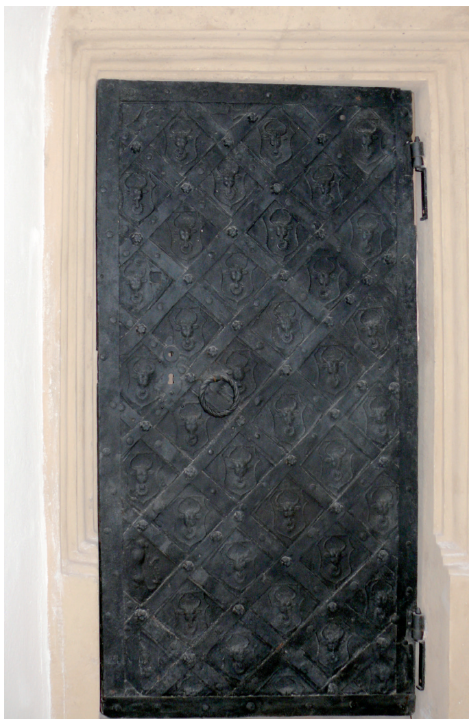
Obr. 5. Kované dveře, druhotně použité ve vstupu do 3. patra věže. – Abb. 5. Sekundär verwendete beschlagene Eingangstür im 3. Geschoss des Turmes.
