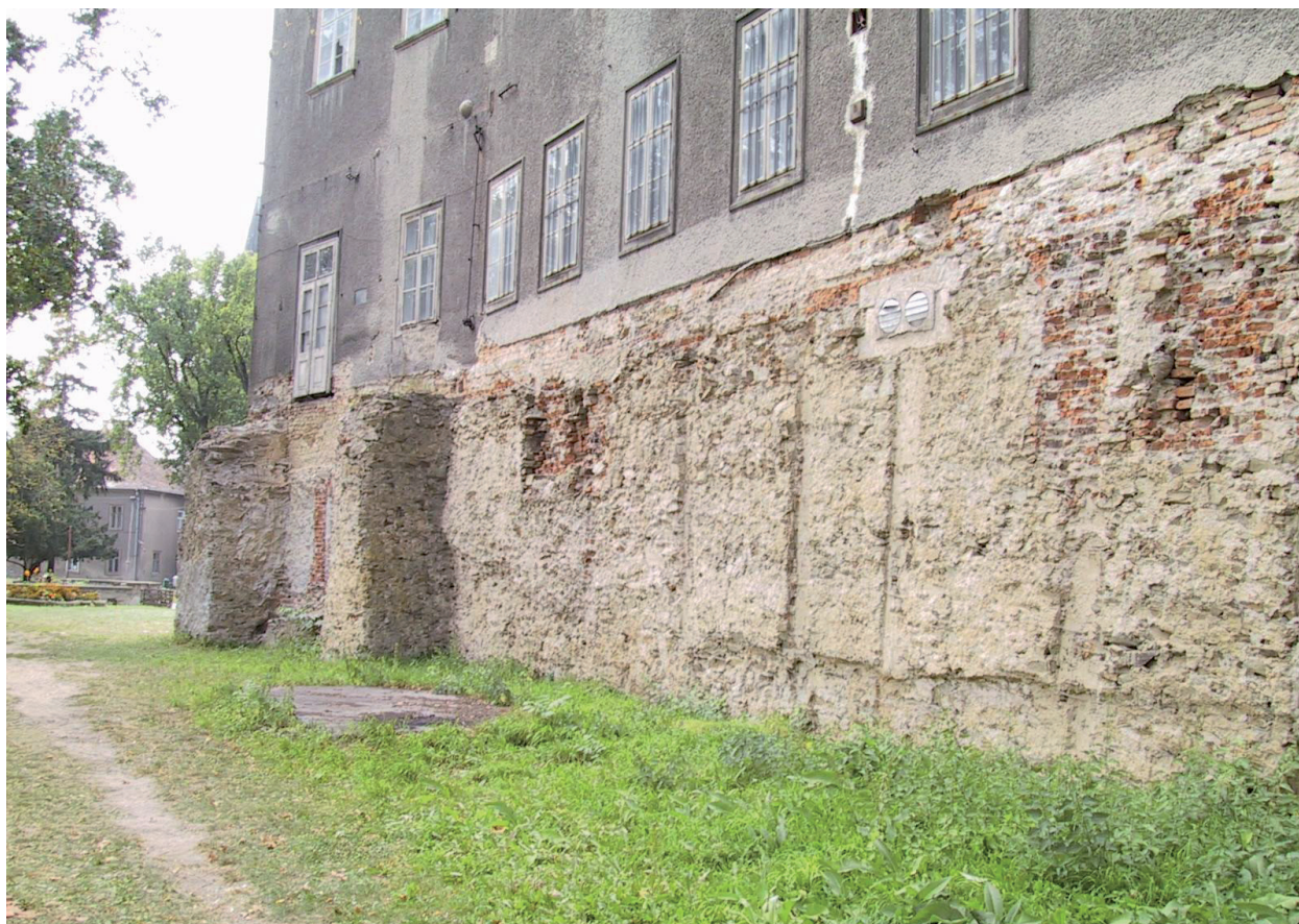
Obr. 2. Spodní část vnější stěny jihovýchodního křídla. Foto: F. R. Václavík 2003. – Abb. 2. Unterteil der Außenmauer des südöstlichen Flügels (Fotografie F.R. Václavík 2003).
