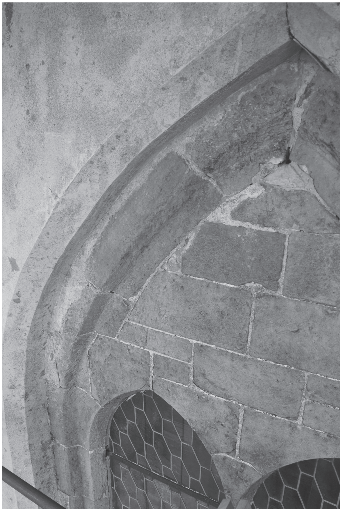
Obr. 26. Bezděz. Okno kaple, typické prozděnými pískovcovými panely, provázanými s jednoduše profilovanými špaletami. Foto L. Kursová, 05. 08. 2015. – Abb. 26. Bezděz. Fenster der Kapelle, typisch sind durchgemauerte Sandsteintafeln, die durch eine einfach profilierte Laibung verbunden sind. Foto L. Kursová, 05. 08. 2015.
