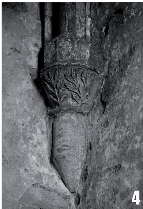
Obr. 12. Bezděz. Konzola a přípory 3. jednotky zprava. Poloha viz obr. 02. Foto L. Kursová, 08. 06. 2002. – Abb. 12. Bezděz. Konsole und Dienste der 3. Einheit von rechts. Zur Lage siehe Abb. 02. Foto: L. Kursová; 08. 06. 2002.
