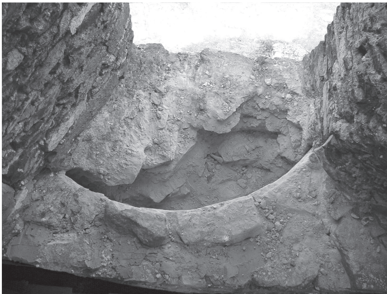
Obr. 27. Bezděz. Relikt tubusu pro vřetenové schodiště z 1. patra do přízemí tzv. Královského paláce. Odkryto při stabilizaci 5. jednotky zprava v podlaze výklenku bývalého okna do nádvoří. Foto K. Podroužek, 30. 06. 2003. – Abb. 27. Bezděz. Relikt des Tubus der Wendeltreppe aus dem ersten Stock ins Erdgeschoss des sog. Königlichen Palas. Bei der Stabilisierung der 5. Einheit von rechts im Boden der Nische des ehemaligen Fensters in Hofrichtung freigelegt. Foto K. Podroužek, 30. 06. 2003.
