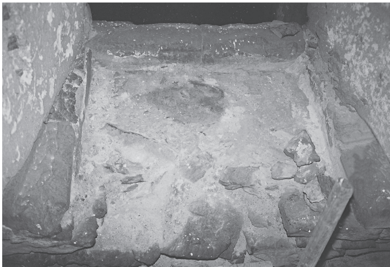
Obr. 29. Bezděz. Odsekaná přímá středověká špaleta, upravená na rozevírající se špaletu, vzniklá při úpravě na klášter v 1. patře mezi 4. a 5. jednotkou zprava. Foto L. Kursová, 08. 06. 2002. – Abb. 29. Bezděz. Gehauene, gerade mittelalterliche Fensterlaibung, später in ein geschrägtes Gewände umgewandelt, entstanden beim Umbau der Burg zum Kloster im 1. Stock zwischen der 4. und 5. Einheit von rechts. Foto L. Kursová, 08. 06. 2002.
