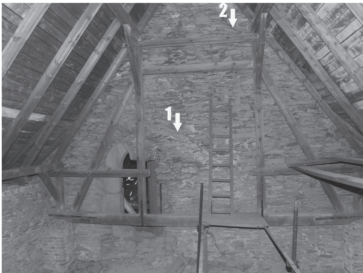
Obr. 25. Bezděz. Levý štít tzv. Královského paláce a pravý štít kaple. Pohled ze zvýšeného podkroví paláce. 1–spára předpokládaného štítu kaple, 2–spára nadezdívky štítu pro palác. Foto L. Kursová, 05. 08. 2015. – Abb. 25. Bezděz. Linker Giebel des sog. Königlichen Palas und rechter Giebel der Kapelle. Blick vom erhöhten Dachboden des Palas. 1–Fuge des angenommenen Kapellengiebels, 2–Fuge des Kniestocks des Giebels für den Palas. Foto L. Kursová, 05. 08. 2015.
