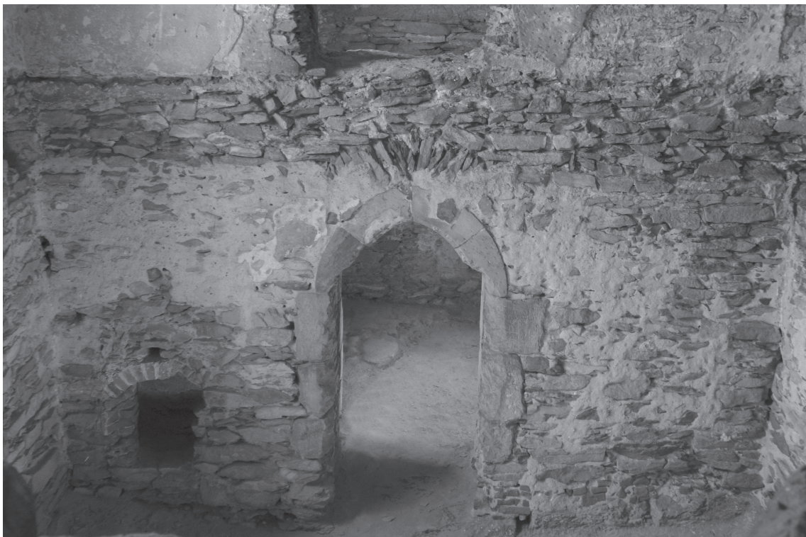
Obr. 6. Bezděz. Přízemí tzv. Královského paláce, 4. jednotka zprava se vstupem do třetí jednotky. Foto L. Kursová, 20. 07. 2004. – Abb. 6. Bezděz. Erdgeschoss des sog. Königlichen Palas, 4. Einheit von rechts mit Zugang zur dritten Einheit. Foto L. Kursová, 20. 07. 2004.
