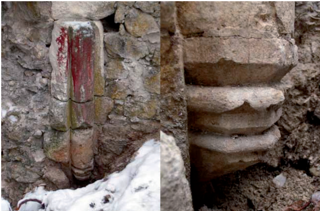
Obr. 6. Greben. Detail klenebních přípor v prostorách hradní kaple (podle Korunek 2014, 74, obr. 11 a 12). – Abb. 6. Greben. Detail der Gewölbedienste in der Burgkapelle (nach Korunek 2014, 74, Abb. 11 und 12).
