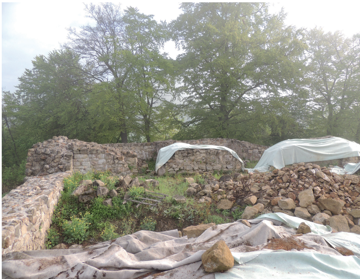
Obr. 15. Vrbovec. Dochované zdivo trojdílného paláce. Foto autor, 2016. – Abb. 15. Vrbovec. Erhaltenes Mauerwerk des dreiteiligen Palas. Foto Autor, 2016.
