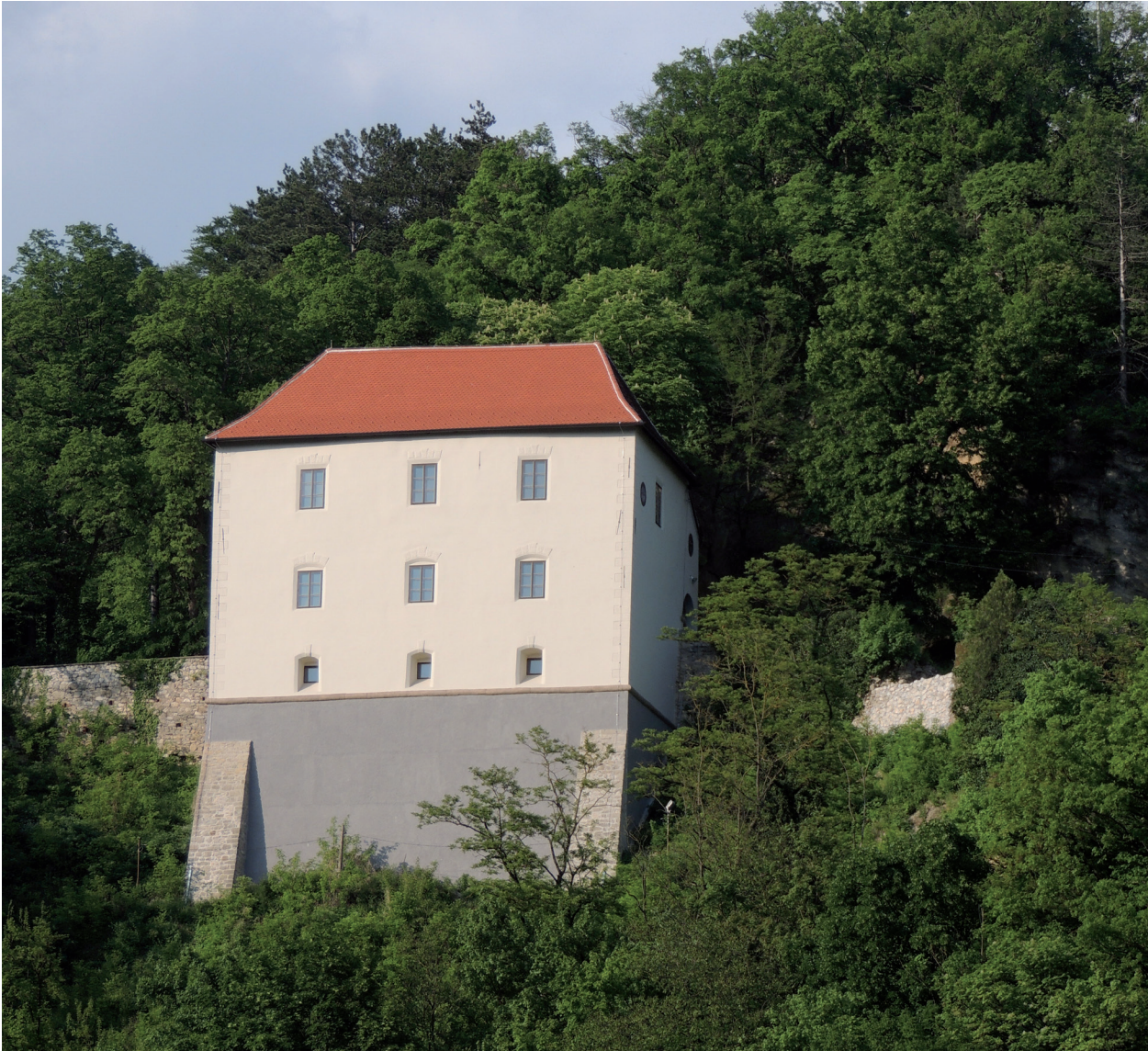
Obr. 13. Krapina. Jihozápadní úsek obvodové hradby s palácem. Foto autor, 2016. – Abb. 13. Krapina. Südwestlicher Abschnitt der Außenmauer mit Palas. Foto Autor, 2016.
