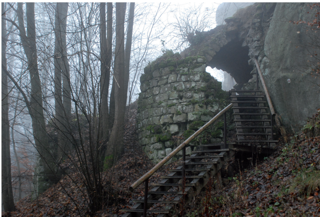
Obr. 14. Hrad Skály (Bischofstein). Jižní a jihovýchodní hradba se zaobleným nárožím a mohutným opěrákem na západní straně. Foto L. Kursová. – Abb. 14. Burg Skály (Bischofstein). Südliche und südöstliche Burgmauer mit gerundeten Ecken und mächtigem Stützpfiler auf der Westseite. Foto L. Kursová.
