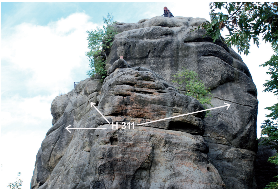
Obr. 13. Hrad Skály (Bischofstein). Vysekané žlábký (H 311) po střeše (vznačeno bílou šipkou), přiložené k jihozápadní stěně vyššího bloku. Foto L. Kursová. – Abb. 13. Burg Skály (Bischofstein). Gehauene Rinnen (H 311) als Überreste eines Dachs (mit weißen Pfeilen markiert), das an die südwestliche Wand des höheren Felsblocks anschloss. Foto L. Kursová.
