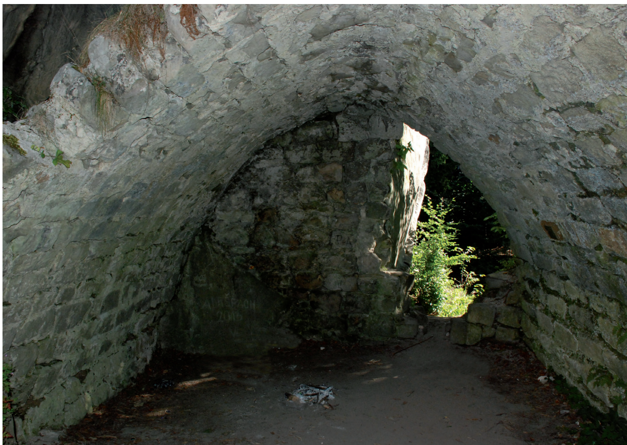
Obr. 15. Hrad Skály (Bischofstein). Lomená valená klenba přizemí při jižní straně nižšího jihozápadního bloku skalního suku B. Foto L. Kursová. – Abb. 15. Burg Skály (Bischofstein). Durchbrochenes Tonnengewölbe im Erdgeschoss an der Südseite des niedrigeren südwestlichen Blocks von Fels B. Foto L. Kursová.
