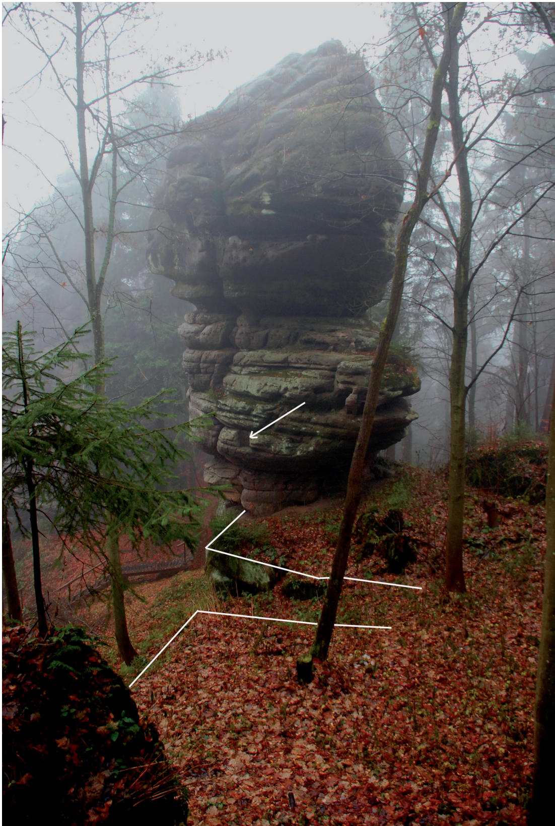
Obr. 7. Hrad Skály (Bischofstein). Skalní suk A s trámovou kapsou (H 211, vyznačena šipkou) a hrana terasy, přerušená stoupající rampou (vyznačena bílou křivkou). Foto L. Kursová. – Abb. 7. Burg Skály (Bischofstein). Fels A mit Balkenloch (H 211, mit Pfeil markiert) und Rand der Terrasse, unterbrochen durch die ansteigende Rampe (durch weiße Linie abgebildet). Foto L. Kursová.
