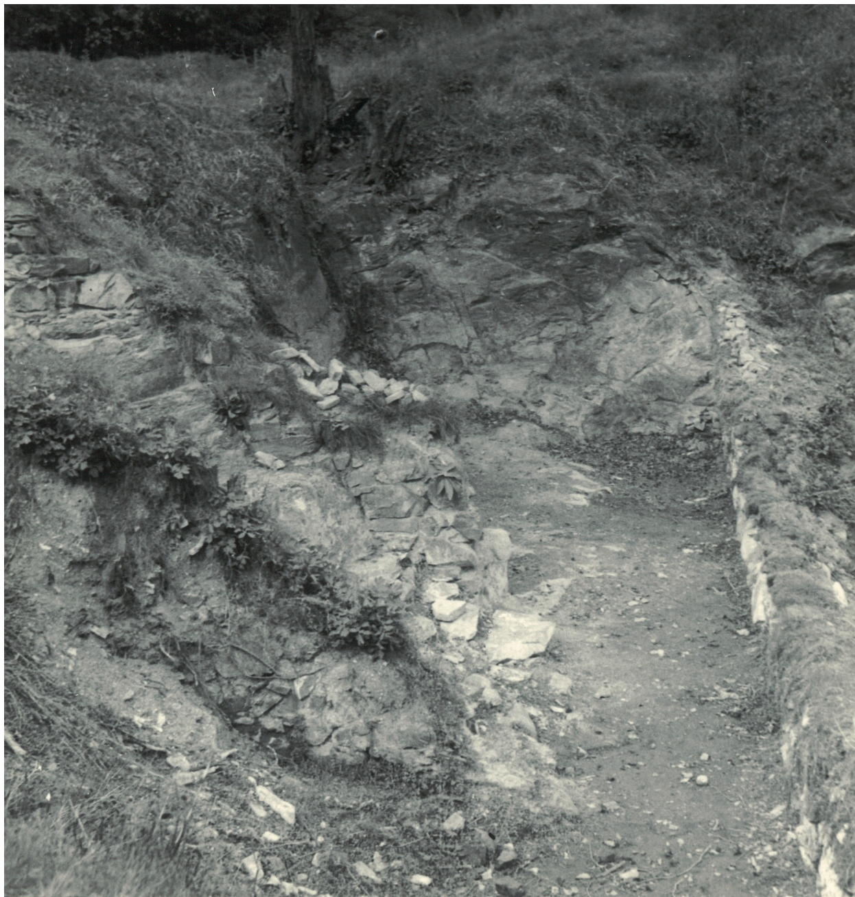
Ů.34. Severní část sklepa v paláci vytesaný ve skále. V-př V předu zeď schodiště.
