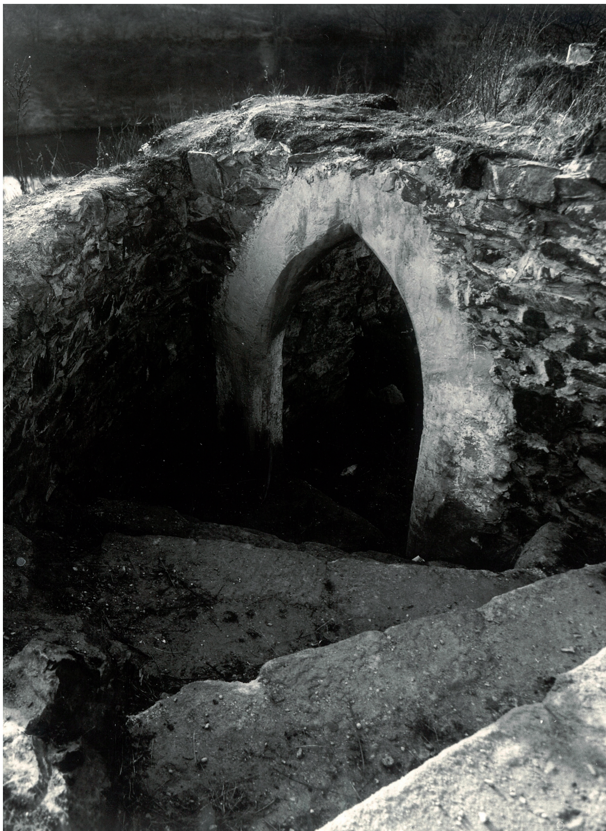
Obr. 86. Věžka. Vstup po suterénu objektu v jádře hradu. Foto V. Uchytíl. Úprava J. Hložek. – Abb. 86. Věžka. Eingang in das Untergeschoss eines Objekts in der Kernburg. Foto V. Uchytíl. Bearbeitung J. Hložek.
