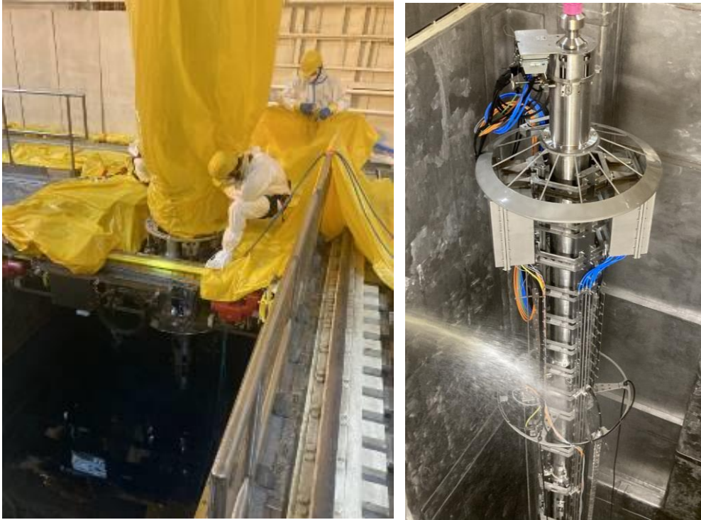
Obr. 7: Demontáž inspekčního sloupu z B02 a jeho dekontaminace oplachem
