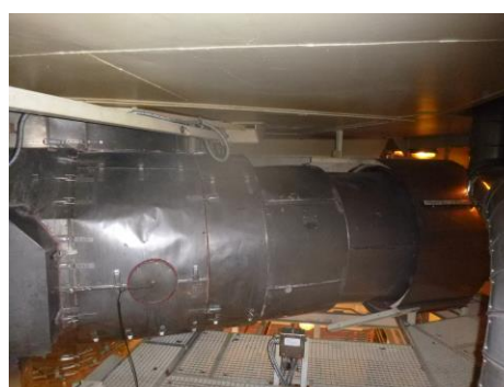
Obr. 2: Umístění ultrazvukových snímačů na ETE 2. bloku na 1. hlavním cirkulačním potrubí
