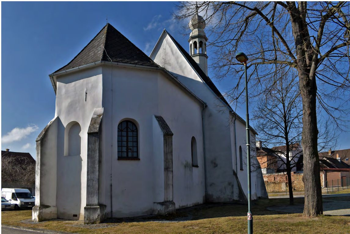
Obr. 3. Lomnice nad Lužnicí – bývalá hradní kaple sv. Václava. Pohled od východu (foto autor, únor 2022). – Fig. 3. Former Castle Chapel of St. Wenceslaus. View from the east (author's photo, February 2022).
