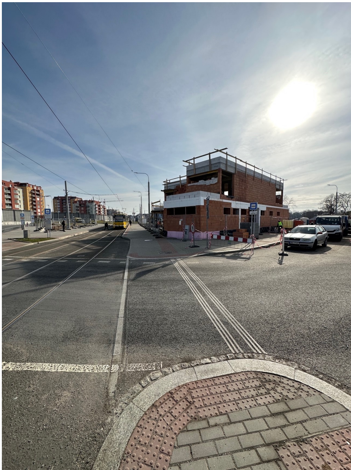
Obr. 13: Výstavba zázemí u záchytné parkoviště P + R Dobřanská
