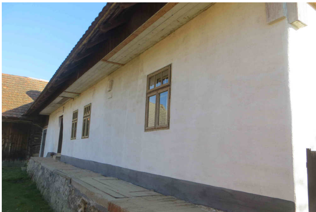
Obrázek 17: Stěna do dvora po obnově kožichu s nátěry vápennou ličkou.
