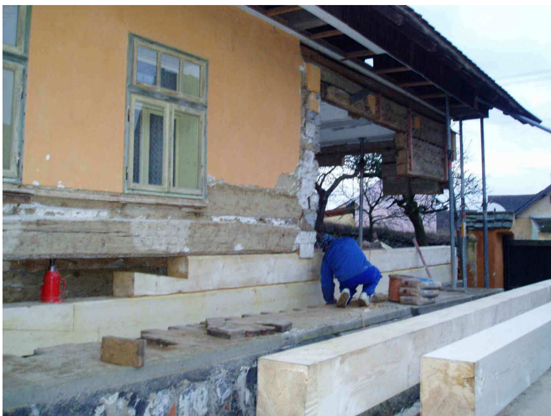
Obrázek 7: Montáž prvních trámů stěny do dvora. Zdroj: archiv autora.
