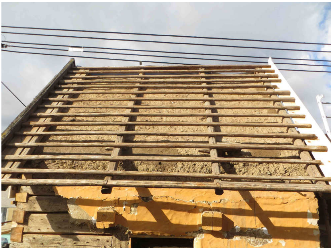
Obrázek 26: Detail konstrukce střechy špýcharu po odstranění střešní krytiny.
