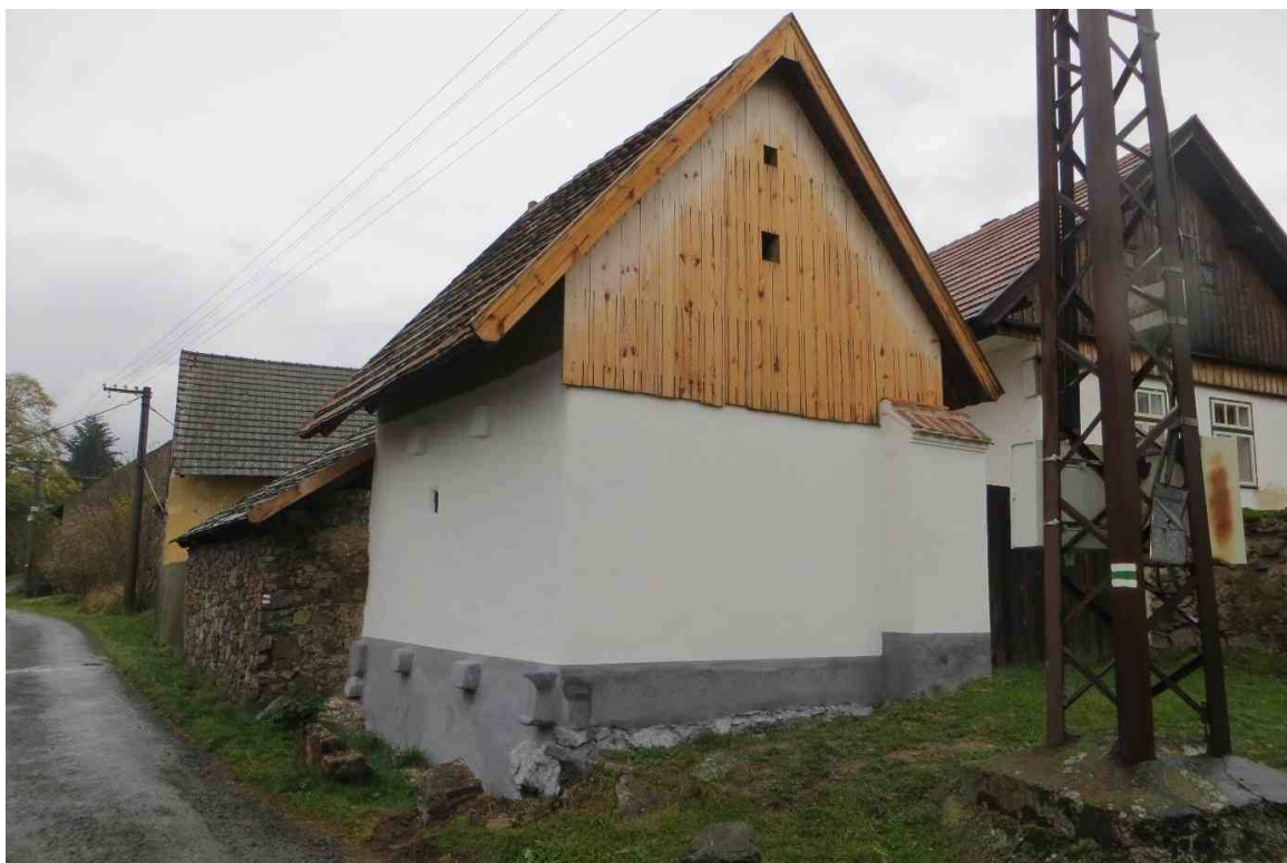
Obrázek 27: Špýchar po dokončené obnově v roce 2018.
