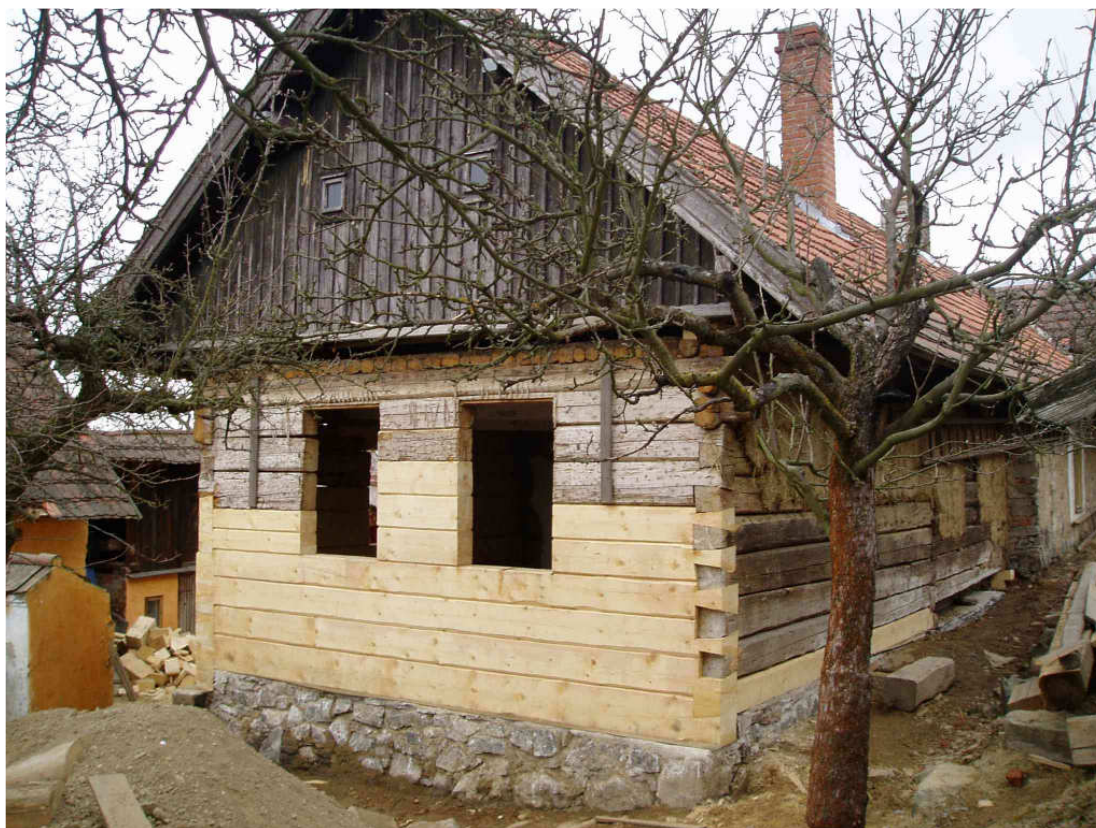
Obrázek 11: Štítová stěna do dvora po výměně roubení.
