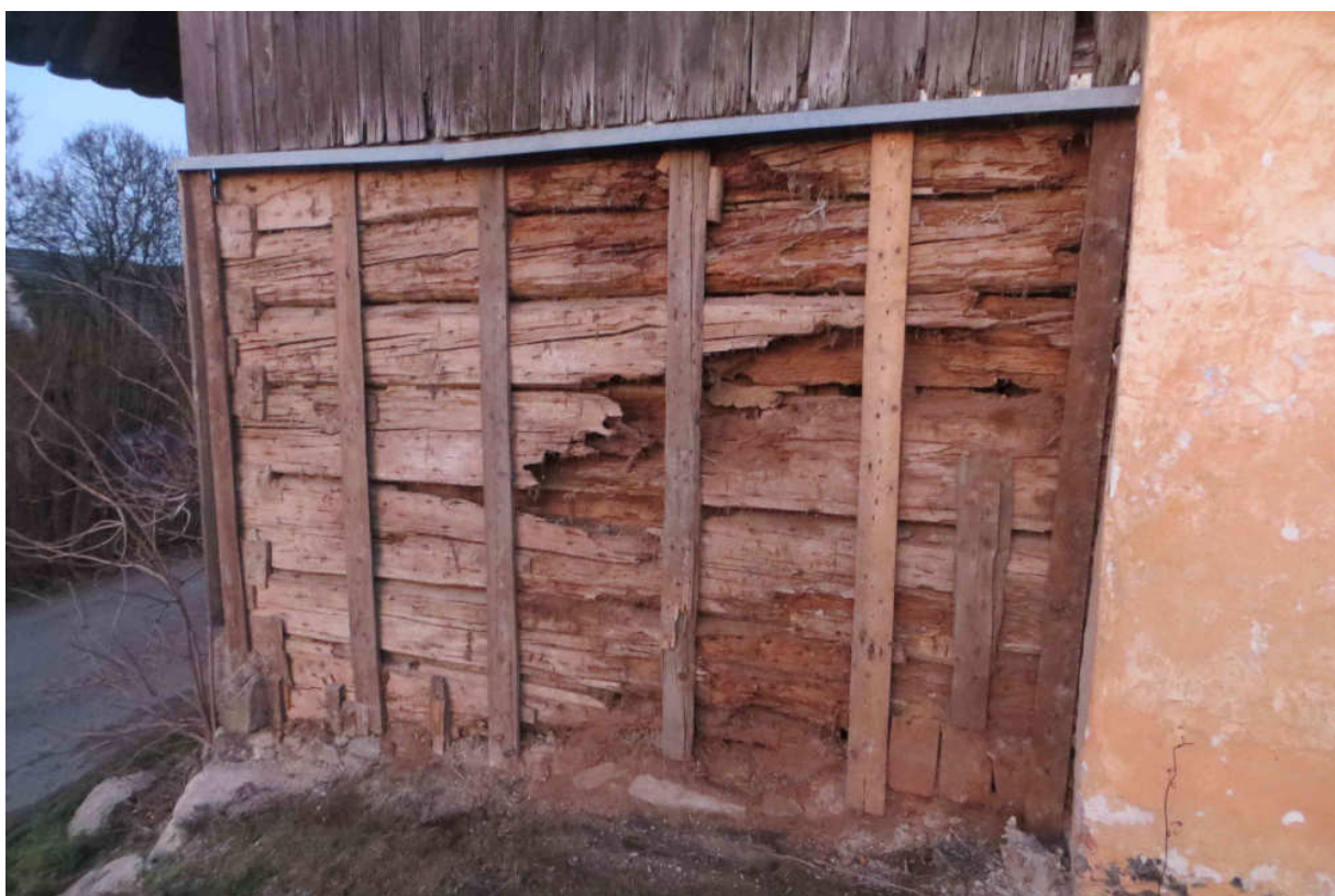
Obrázek 19: Stěna špýcharu po odstranění heraklitových desek.
