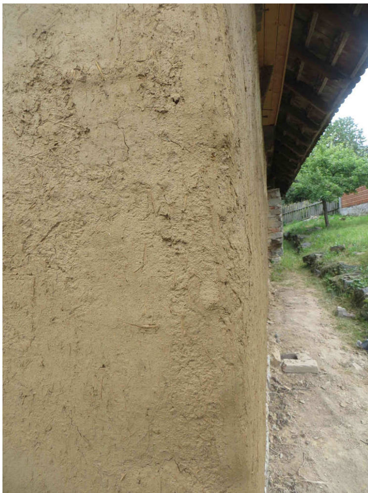
Obrázek 16: Detail povrchu a provedení rohu kožichu.
