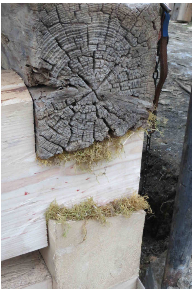
Obrázek 25: Obdobná vrstva mechu v nově opravených spojích. Zdroj: archiv autora.
