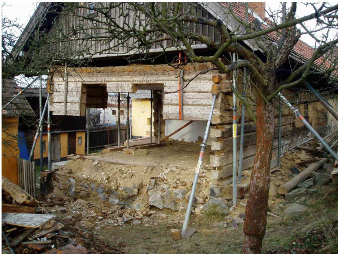
Obrázek 6: Stav roubení štítové stěny po odstranění poškozeného roubení. Zdroj: archiv autora.
