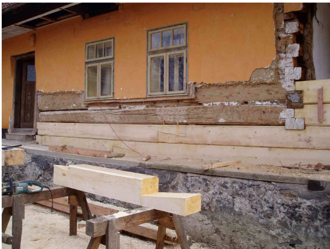
Obrázek 9: Napojení trámů stěny do dvora. Zdroj: archiv autora.
