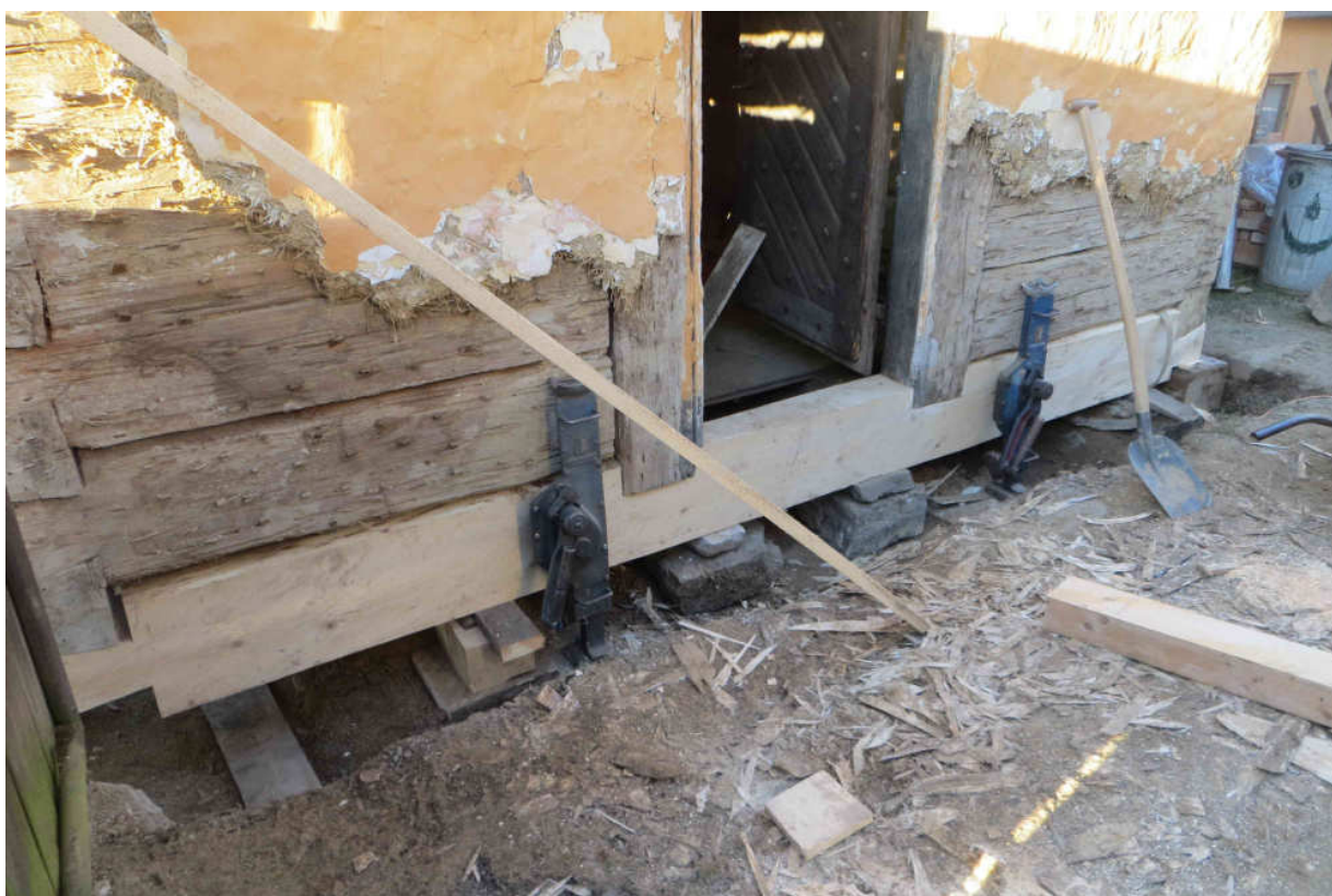
Obrázek 21: Stav prahového trámu špýcharu po výměně. Zdroj: archiv autora.
