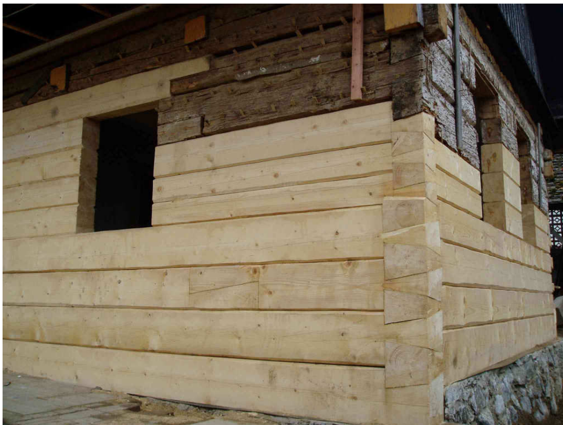
Obrázek 12: Detail spoje na rybinu.
