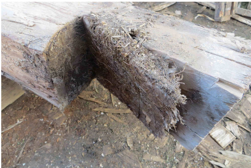
Obrázek 24: Původní vrstva mechu ve spojích trámů. Zdroj: archiv autora.
