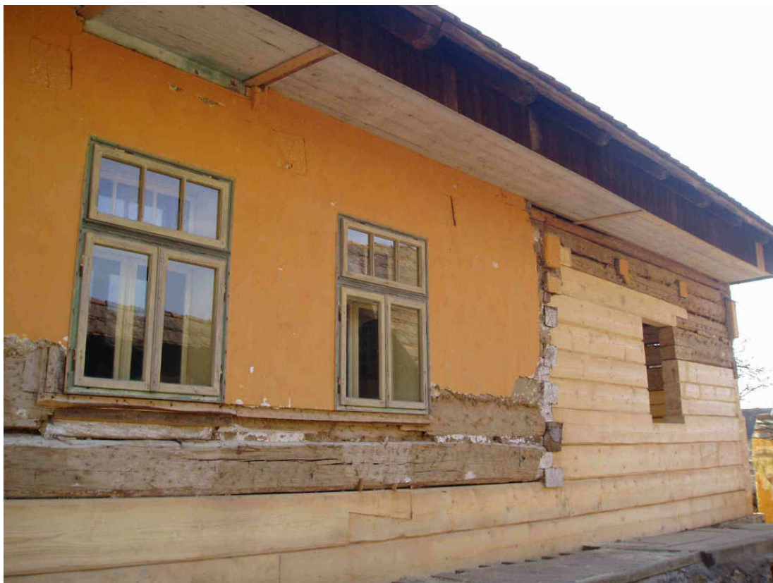
Obrázek 10: Stěna do dvora po výměně roubení.
