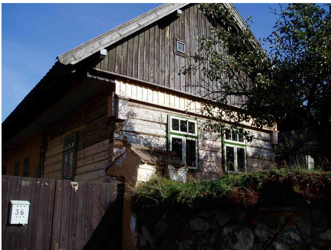
Obrázek 13: Štítová stěna s replikou původních oken.
