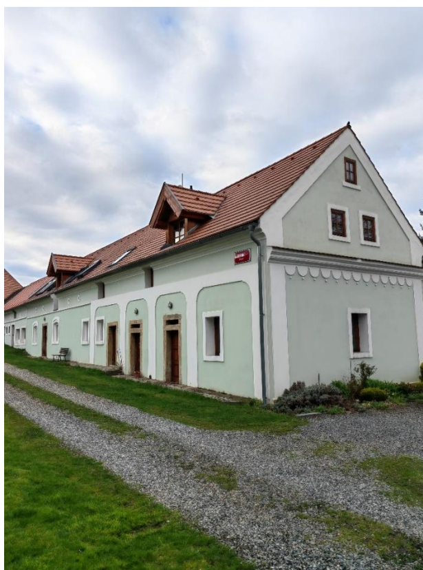
Obr. 62 – VPZ Kyšice – chlévy v rámci usedlosti, náves 15
