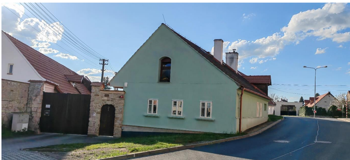
Obr. 25 – VPZ Radčice – Venkovská usedlost č.p. 11
