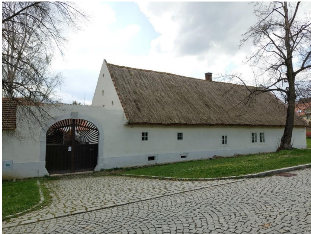
Obr. 38 – VPZ Plzeň 1 – Bolevec, usedlost č.p. 1/3
