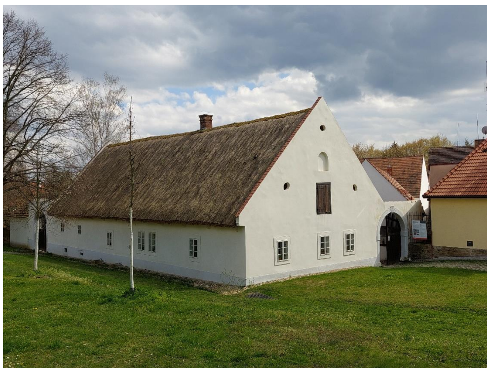
Obr. 39 – VPZ Plzeň 1 – Bolevec, usedlost č.p. 1/3
