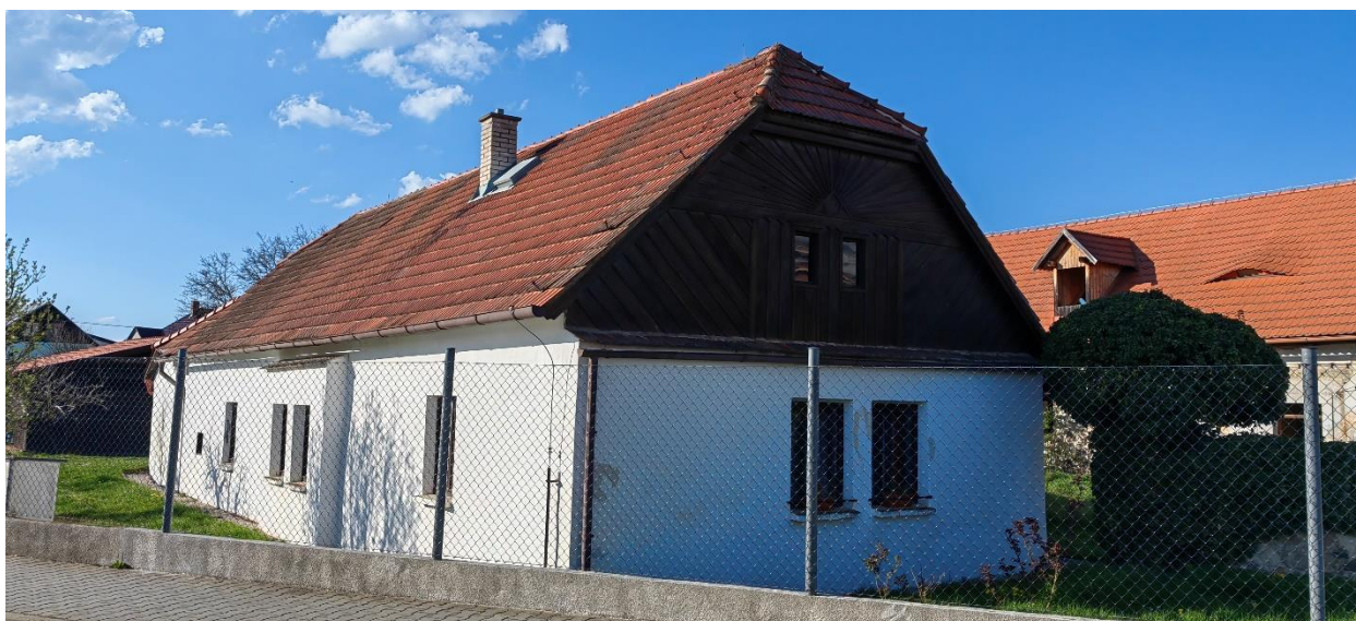
Obr. 23 – VPZ Radčice – Venkovská usedlost č.p. 12
