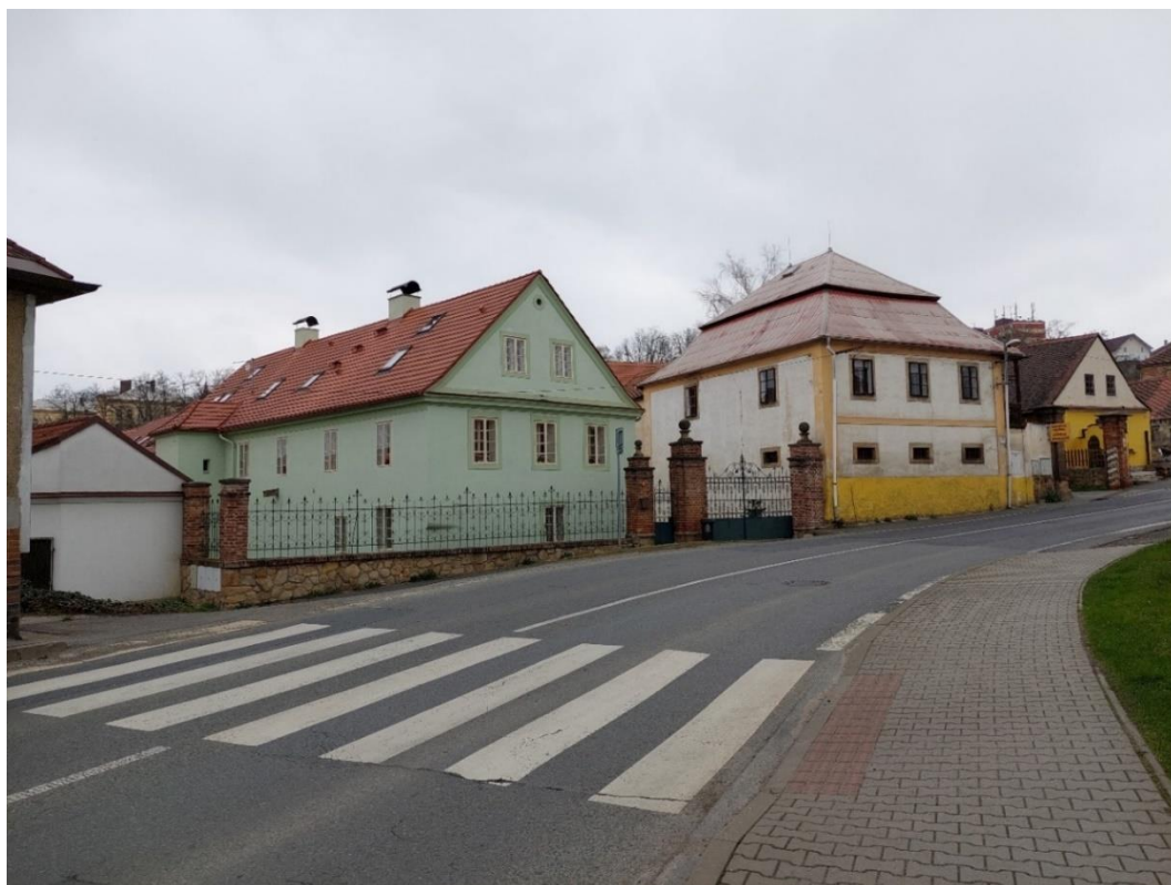
Obr. 52 – VPZ Plzeň 4 – Lobzy – Rychta č.p. 1/5 a venkovská usedlost č.p. 2/4
