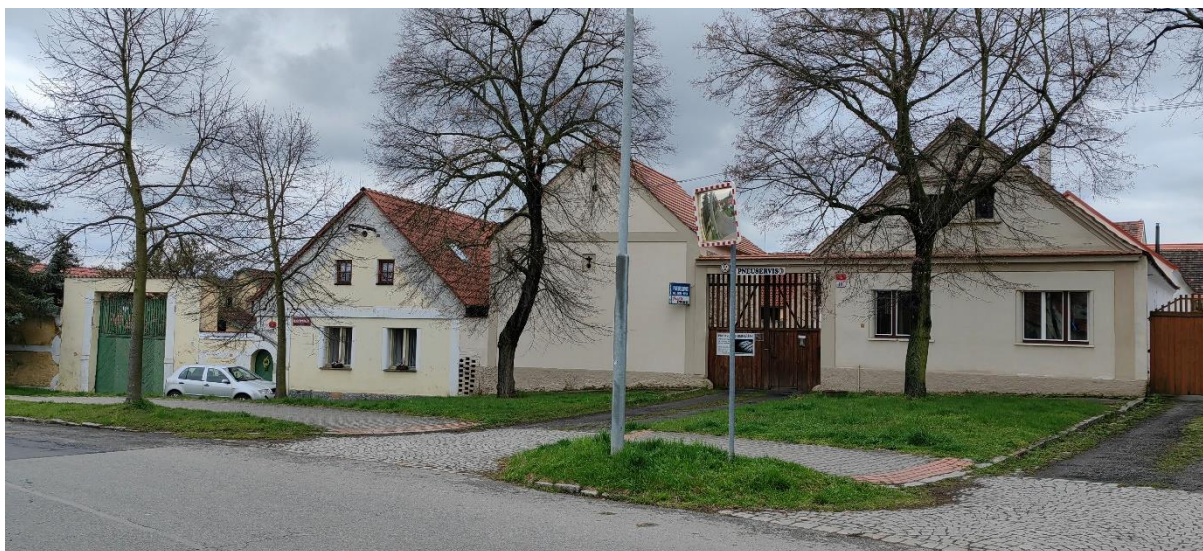
Obr. 49 – VPZ Plzeň 4 – Újezd, pohled na návěsní zástavbu
