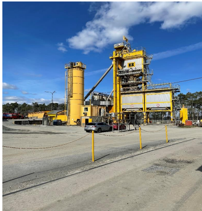
Abbildung 8 Asphaltmischungsanlage (Nová Hospoda) (Foto: die Autorin)
