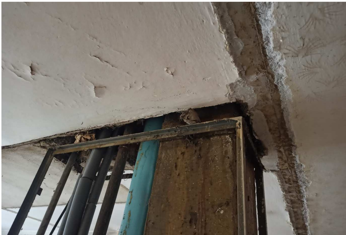
Obr. 6.10 Pohled na instalační panel šířky 1,80 m po vybourání příčky
