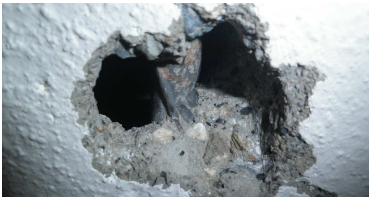
Obr. 6.7: Profilování nosného prutu Ø14 instalačního panelu (Ke Špitálskému lesu, Plzeň)
