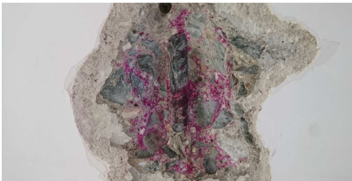
Obr.6.4: Žebrování prutu \varnothing 10 s orientační zkouškou karbonatice (Ke Špitálskému lesu, Plzeň)
