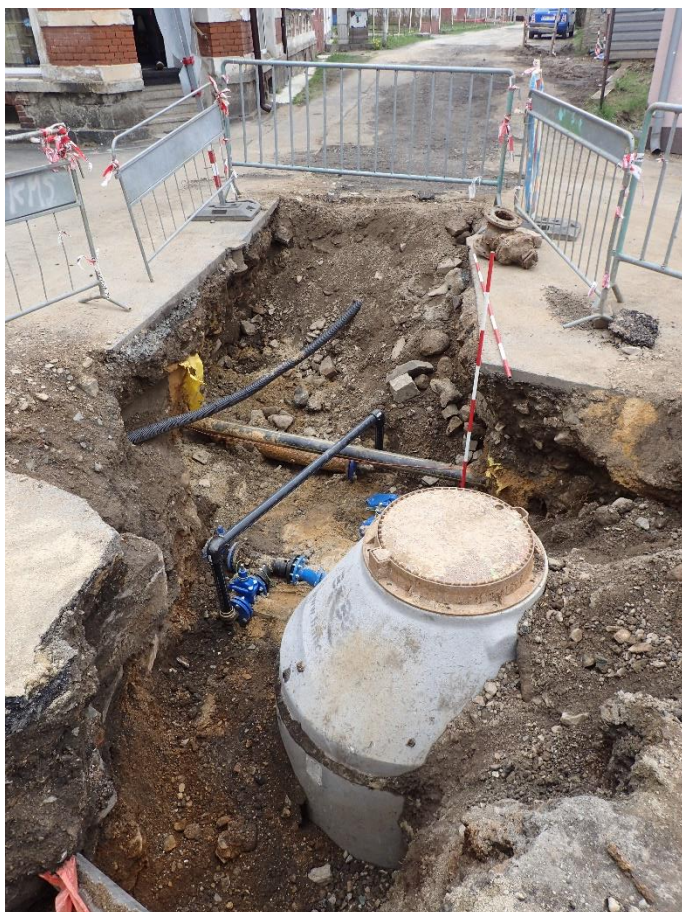
Obr. 96: Fotografická dokumentace výkopu záchranného výzkumu v ulici Lipová cesta v Kraslicích (zdroj: Muzeum Cheb).
