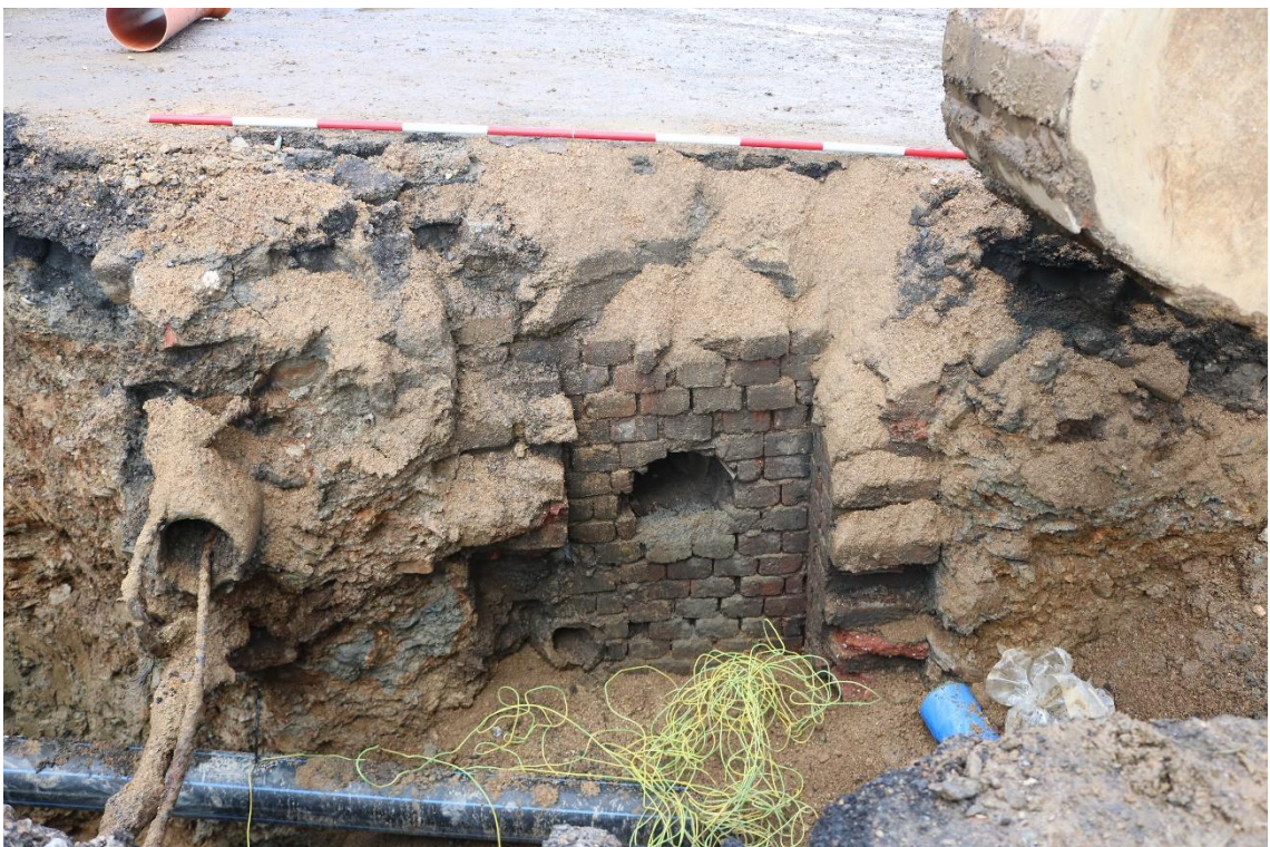
Obr. 15: Detail profilu zobrazující cihlovou kanalizací (foto: autor).
