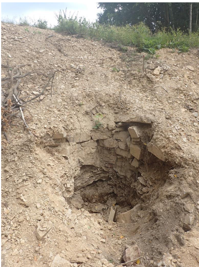
Obr. 16: Fotografická dokumentace studny z roku 2022 (foto: autor).
