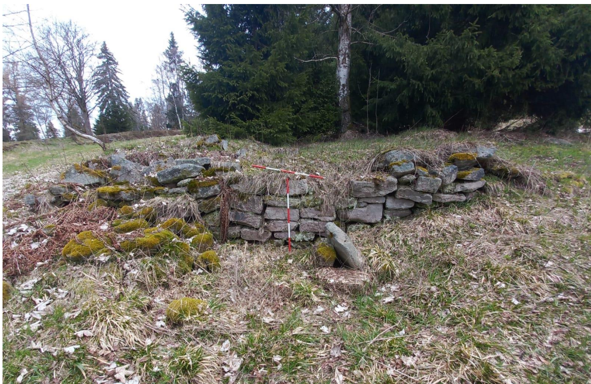
Obr. 45: Dokumentace pozůstatku budovy (foto: autor).
