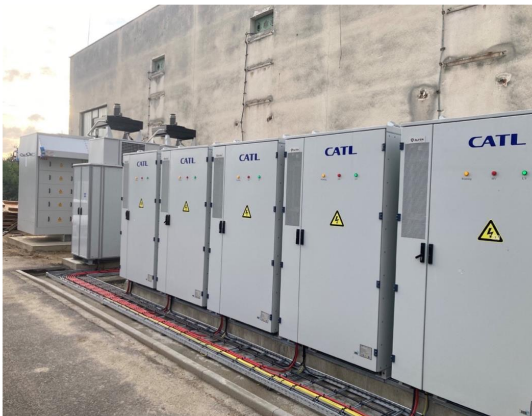
Obr. 13: Konkrétní stavba rackového úložiště [34]
