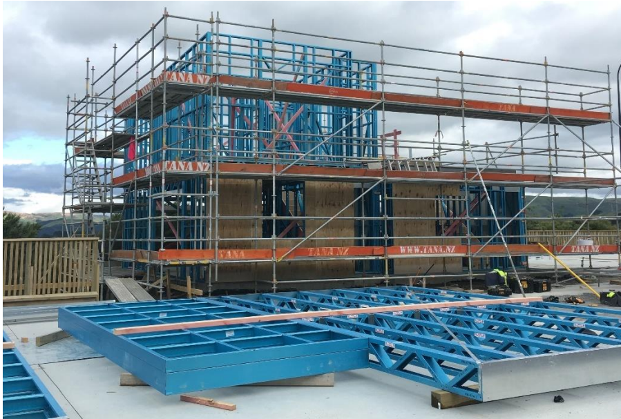
Obr. 69: Stavba vícepodlažního domu – Porirua, Nový Zéland
