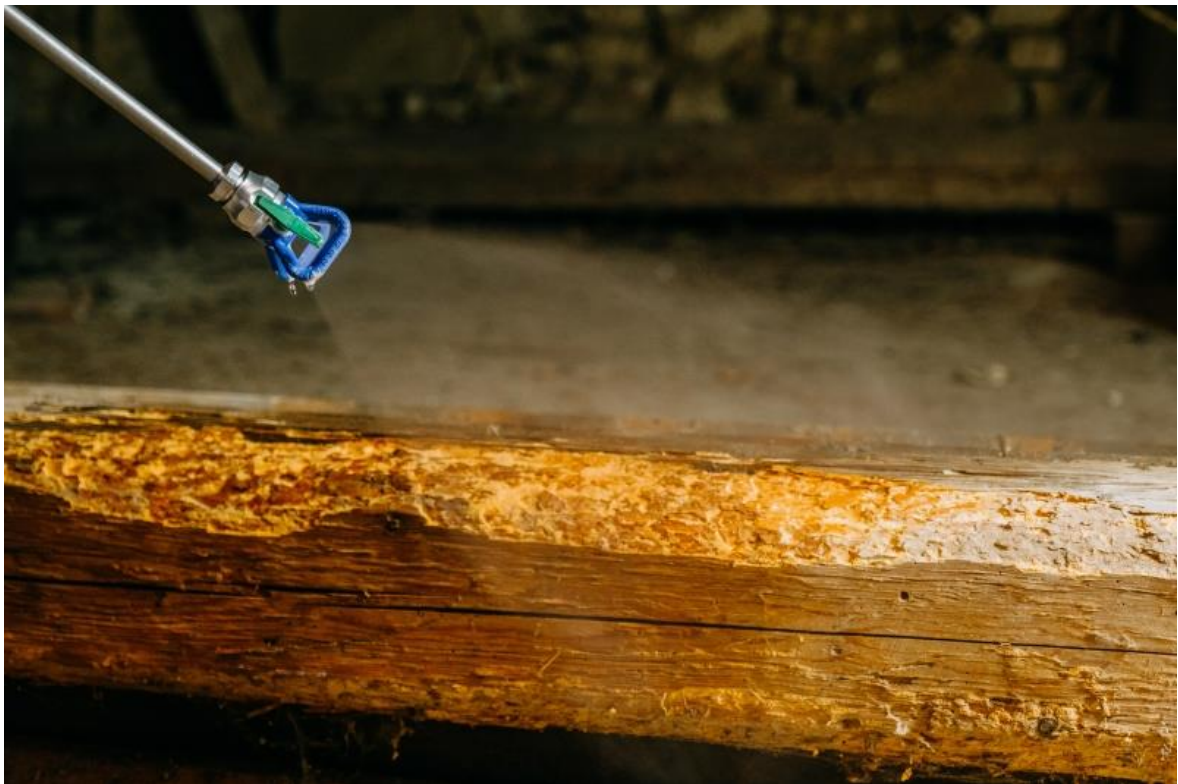
Obrázek 3.4 – Ošetření dřevěného prvku chemickým prostředkem
