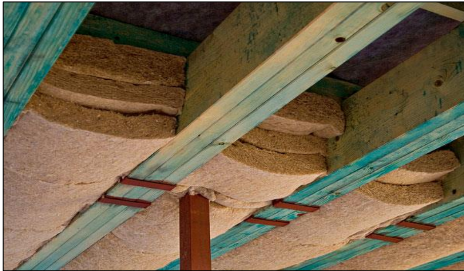
Obrázek 22 - Použití izolace z konopných rohoží ve stropě Zdroj: [38]
