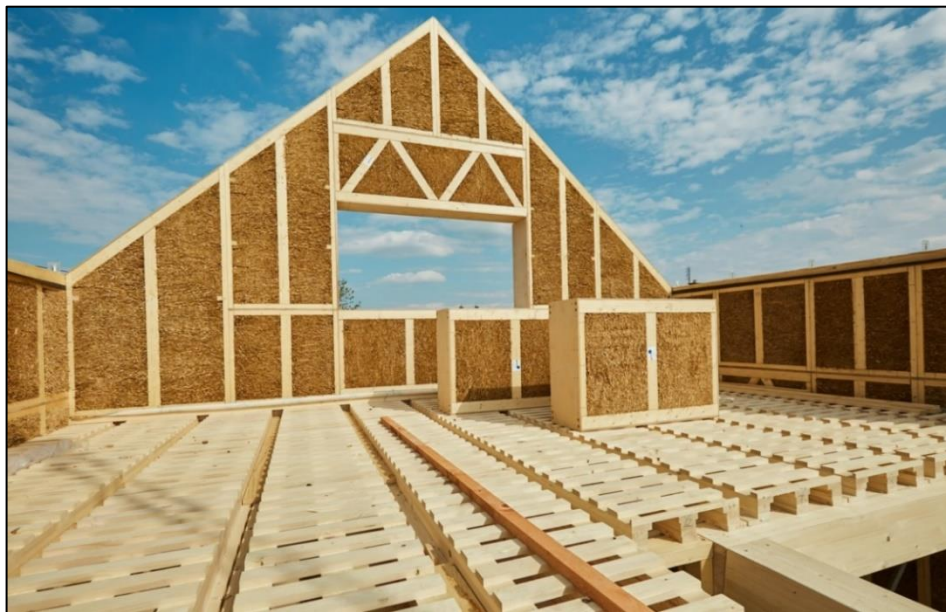
Obrázek 21 - Použití prefabrikovaných slaměných panelů Zdroj: [37]
