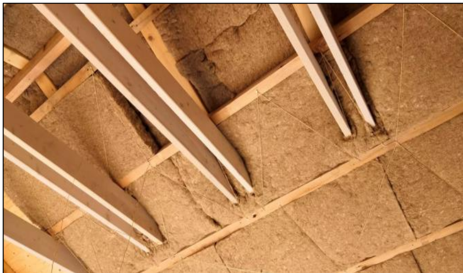
Obrázek 23 - Použití lněné izolace v šikmé střeše Zdroj: [39]
