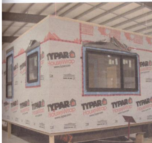
Obrázek 8 - Stavba modulu ve výrobní hale pro dům "X-Line 014" Zdroj: [10]
