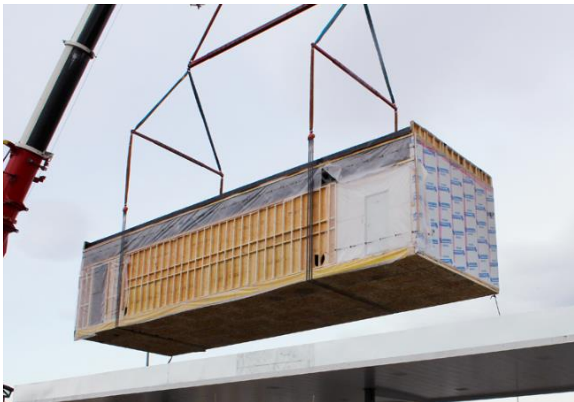
Obrázek 4 - Přeprava stavebního modulu na jeřábu
