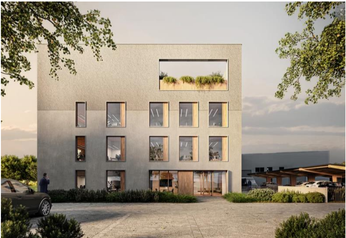
Obrázek 48 - Pasivní čtyřpodlažní dřevostavba, administrativní budova v Plané u Českých Budějovic Zdroj: [33]
