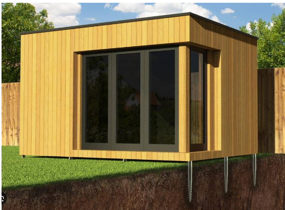
Obrázek 3 - Založení kontejneru na šroubových základech
