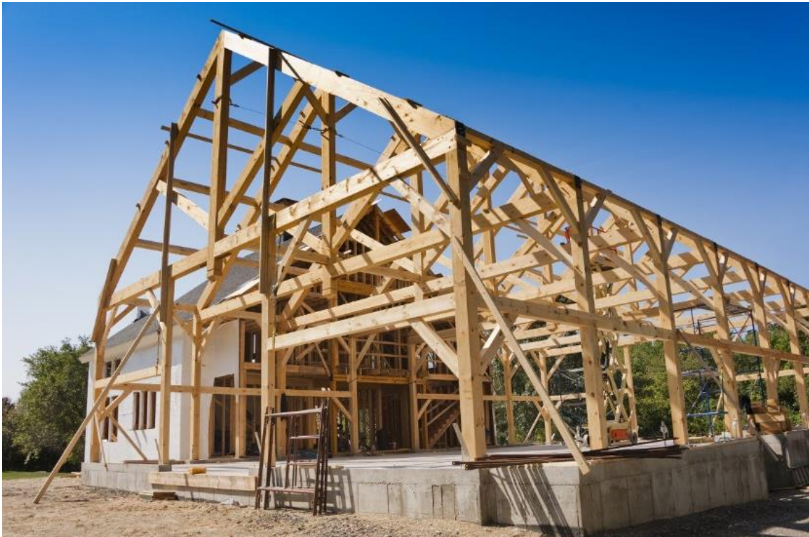
Obrázek 14 - Skeletová dřevostavba během realizace Zdroj: [17]
