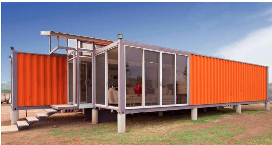
Obrázek 2 - Modulární stavba z nákladních kontejnerů "Containers of Hope" v Kostarice Zdroj: [5]
