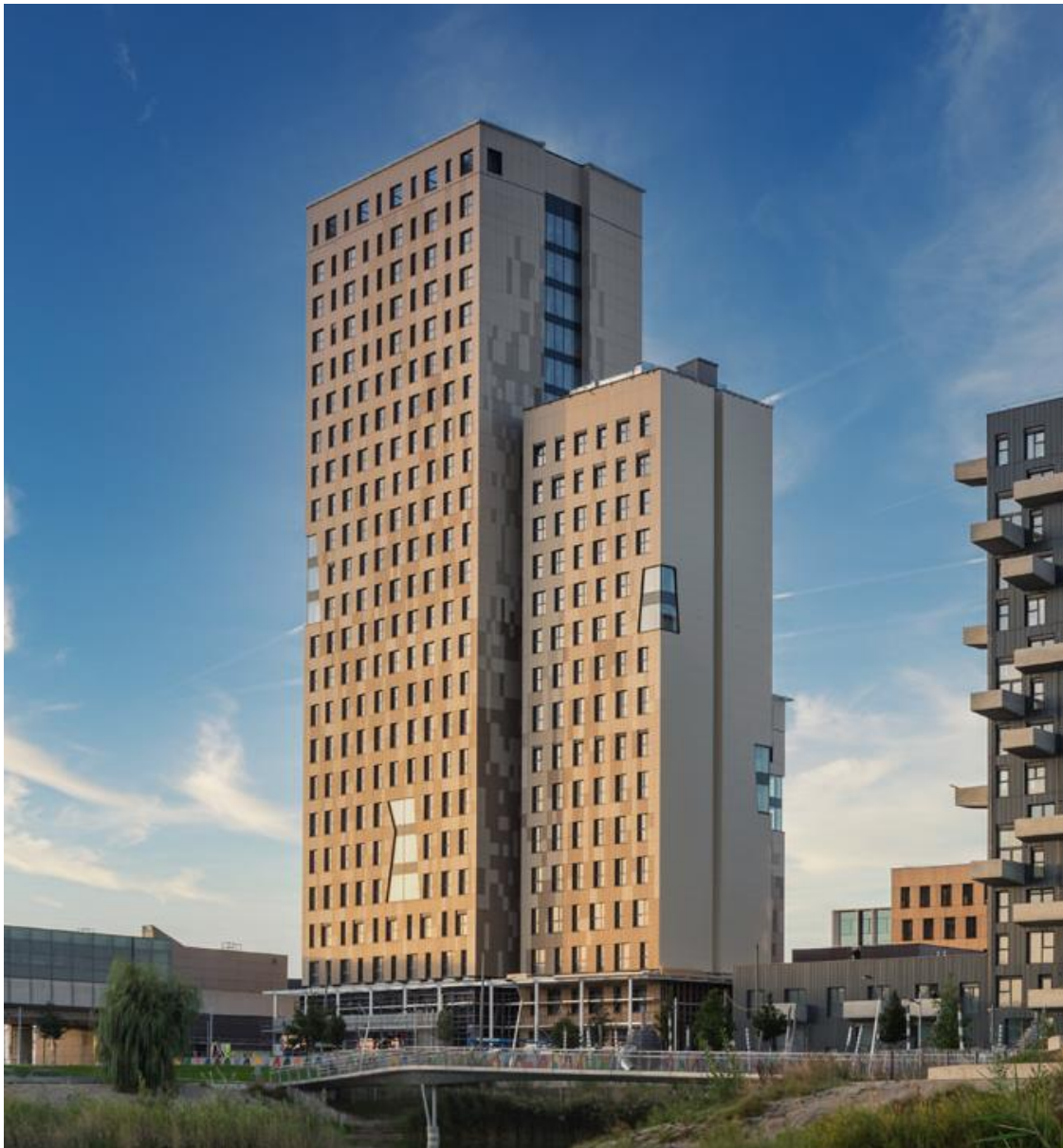
Obrázek 47 - Výšková budova z CLT panelů s názvem "HoHo" ve vídeňské rezidenční čtvrti Aspern Seestadt Zdroj: [31]
