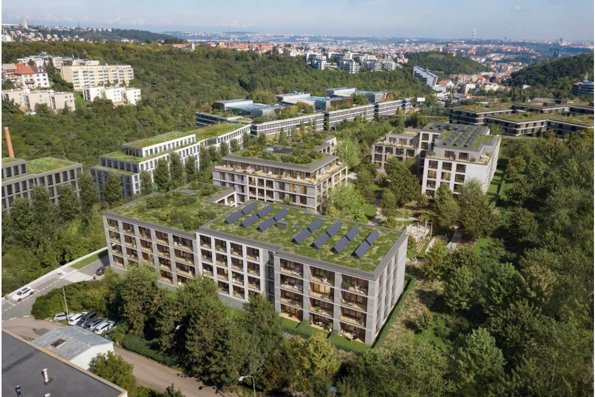
Obrázek 49 - Dřevostavba z CLT panelů v městské čtvrti Radlice v Praze Zdroj: [35]
