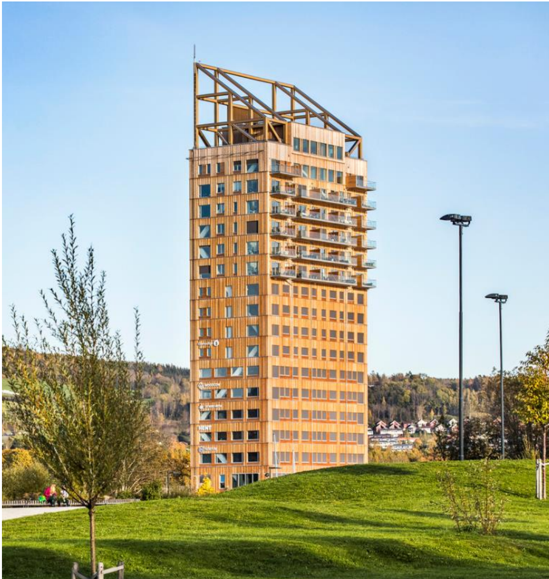
Obrázek 46 - Polyfunkční dům "Mjøstårnet" v Norsku ve městě Brumunddal Zdroj: [29]
