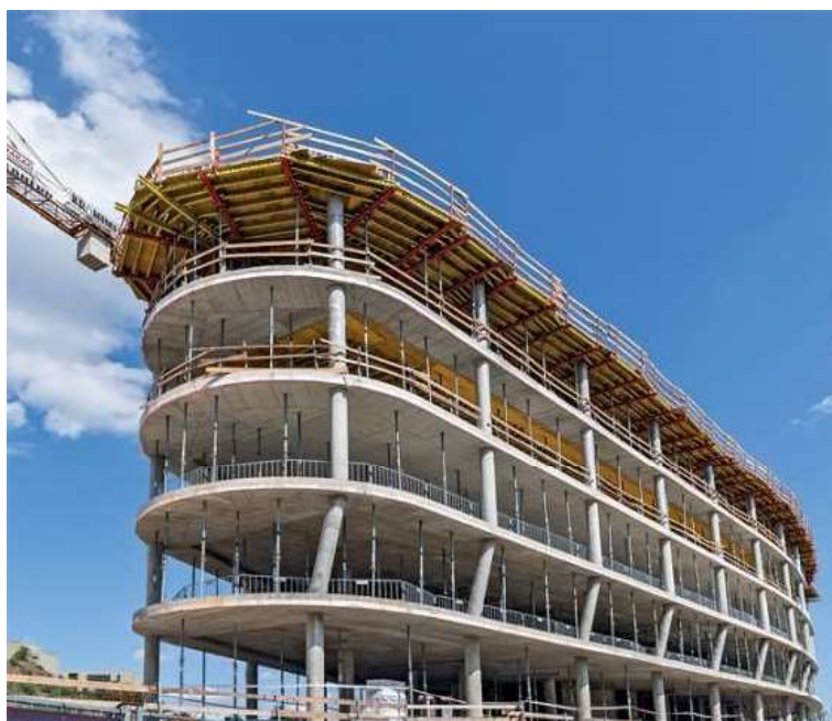
Obrázek 31 - Monolitická bezprůvlaková skeletová stavba
