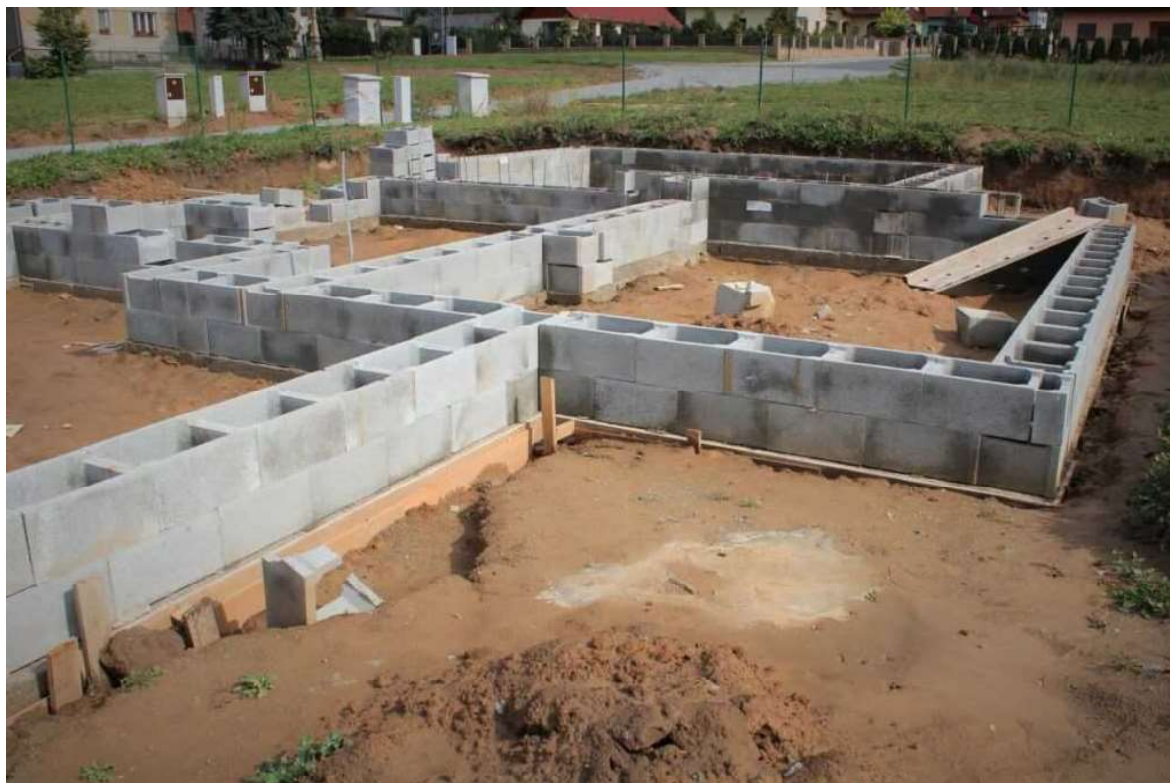
Obrázek 28 - Prefamonolitický systém ztraceného bednění
