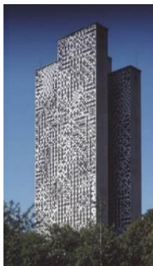
Obr 9: SÝKORA, Zdeněk. Obklad 4 větracích komínů Letenského tunelu, 1969. 49
