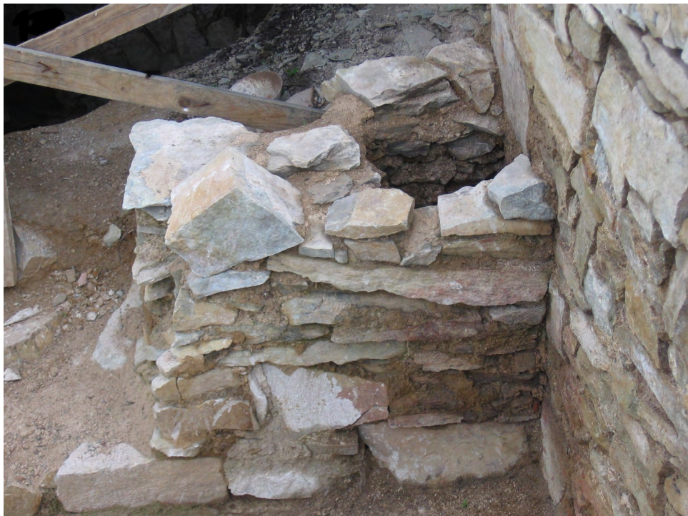
Obr. 16. Brandýs nad Orlicí – hrad. Vertikální kapsa ve struktuře 900 (zdivo mezi místnostmi 1 a 2; foto Z. Skalický). – Fig. 16. Brandýs nad Orlicí – castle. Vertical pocket in the 900 structure (masonry between Rooms 1 and 2; photo by Z. Skalický).
