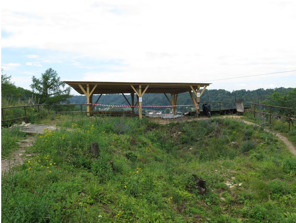
Obr. 4. Brandýs nad Orlicí – hrad. Provizorní přístřešek nad místností 2 a částí místnosti 3 (foto D. Vích, 7. 7. 2017). – Fig. 4. Brandýs nad Orlicí – castle. Temporary shelter over Room 2 and parts of Room 3 (photo by D. Vích, 7. 7. 2017).
