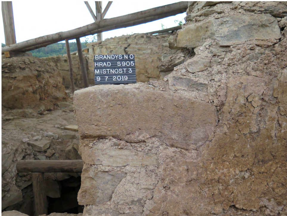
Obr. 15. Brandýs nad Orlicí – hrad. Zazděné pískovcové ostění u průchodu z místnosti 3 do místnosti 2 (pohled z místnosti 3; foto D. Vích). – Fig. 15. Brandýs nad Orlicí – castle. Walled-up sandstone head jamb at the passage from Room 3 to Room 2 (view from Room 3; photo by D. Vích).
