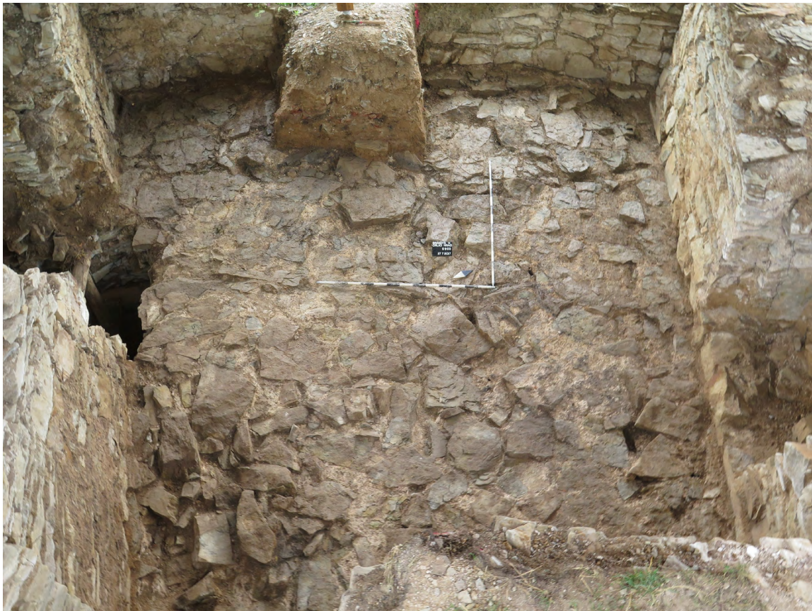
Obr. 6. Brandýs nad Orlicí – hrad. Podlaha místnosti 2 po dokončení výzkumu (foto D. Vích, 27. 7. 2017). V horní části snímku je vidět blok zeminy s ukotvenou stojkou provizorního přístřešku, v pravé spodní části snímku vstup do místnosti 1, v levé horní části snímku vstup do místnosti 3 s propadem klenby a v levé dolní části snímku vstup do snížené centrální části hradního jádra. – Fig. 6. Brandýs nad Orlicí – castle. Floor of Room 2 after completion of the survey (photo by D. Vích, 27. 7. 2017). The block of earth with the anchored support of the temporary shelter can be seen in the upper part of the image; the entrance to Room 1 is in the lower right part of the image; the entrance to Room 3 with collapsed vault is visible in the upper left part of the image and the entrance to the lowered central part of the castle core in the lower left part of the image.
