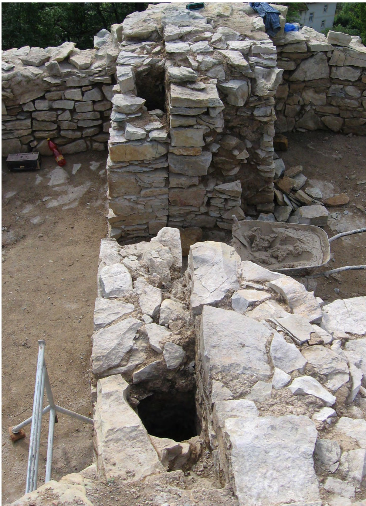
Obr. 12. Brandýs nad Orlicí – hrad. Struktura 905 mezi místnostmi 2 a 3 se zřetelnou stavební spárrou a objevenými kapsami (foto Z. Skalický 4. 9. 2020). – Fig. 12. Brandýs nad Orlicí – castle. Structure 905 between Rooms 2 and 3 with a clear construction joint and discovered pockets (view from Room 3; photo by Z. Skalický, 4. 9. 2020).
