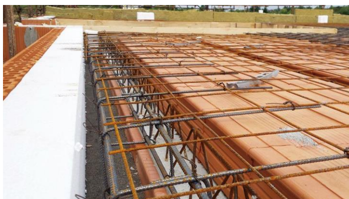
Obrázek č. 49: Současné provádění ztužující železobetonového věnce. [11]
