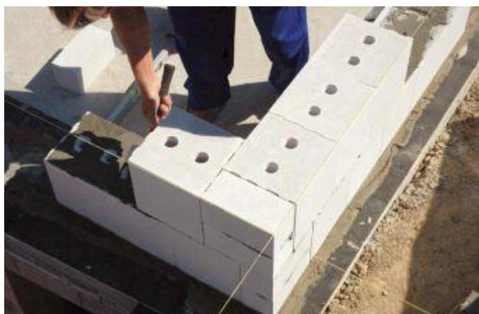
Obrázek č. 20 a 21: Vápenopísková tvárnice a proces zdění z vápenopískových tvárnice. [13], [14]
