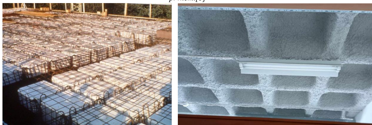
Obrázek č. 78 a 79: Železobetonový vylehčený strop. [5]
