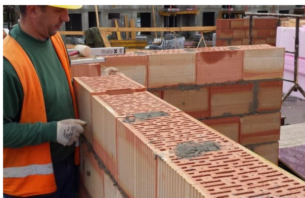
Obrázek č. 18: Proces zdění dutinových keramických tvárnic. [12]
