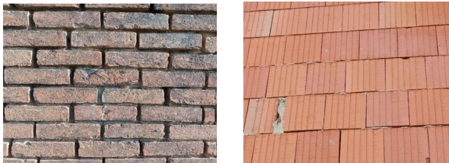
Obrázek č.41 a 42: Běhounová vazba z cihel pálených a vazáková vazba z dutinových bloků. [1]
