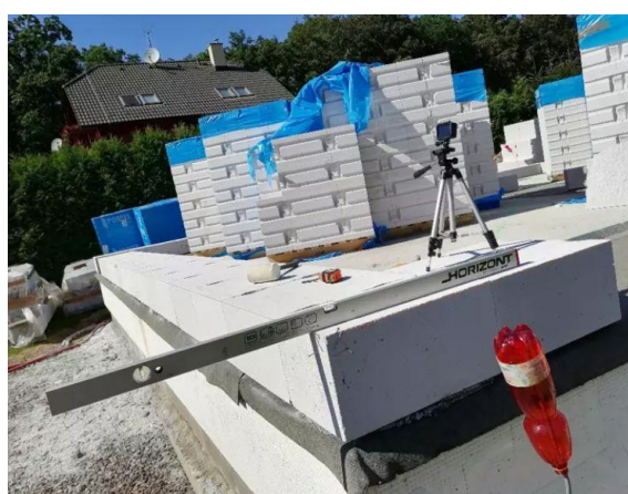
Obrázek č. 24 a 25: Tvárnice z pórobetonu a proces zděné obvodové stěny z pórobetonu. [13],[17]
