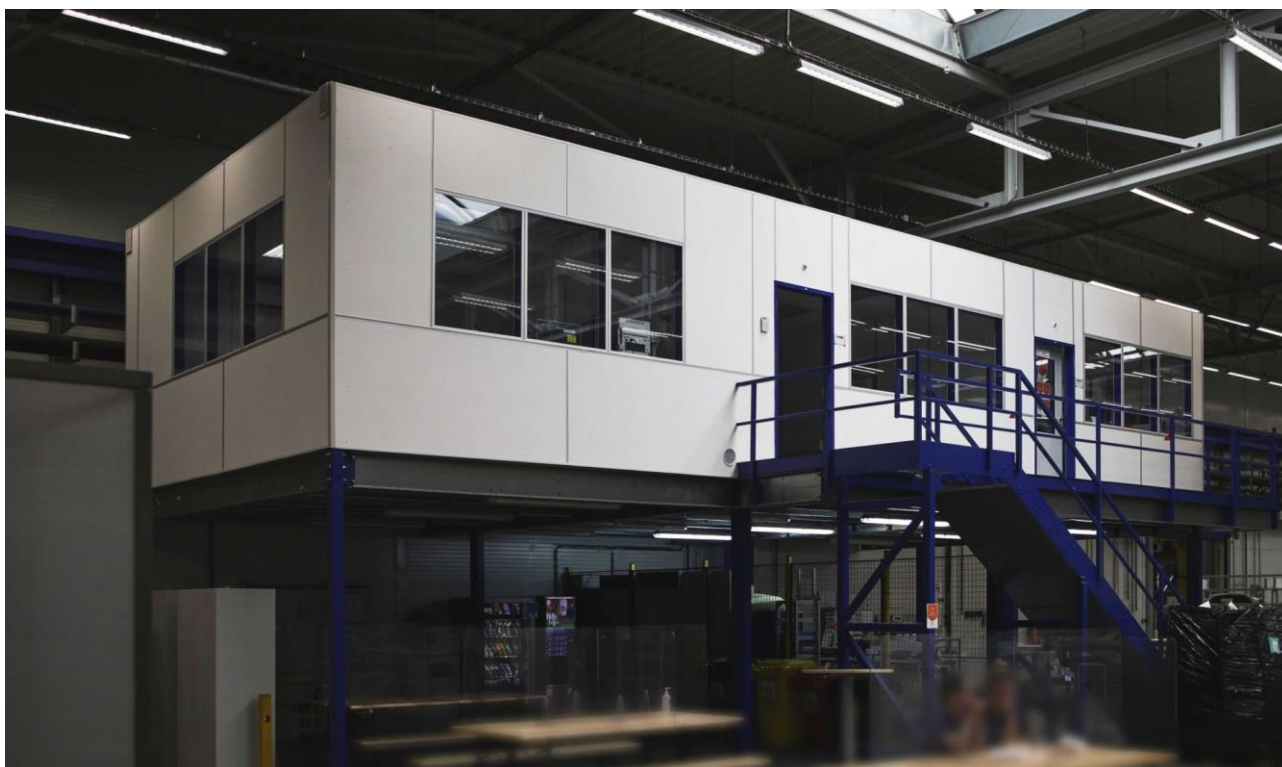
Obrázek č. 1 - Příklad halového zvýšeného vestavku se sendvičovým opláštěním [2]
