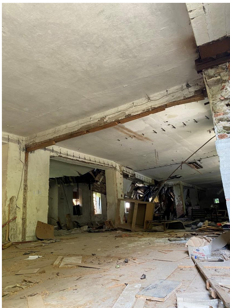
Obr. 53: Opuštěný interiér firmy Bohemia-Werke. 08.03.2023. Foto: Radana Vrbová
