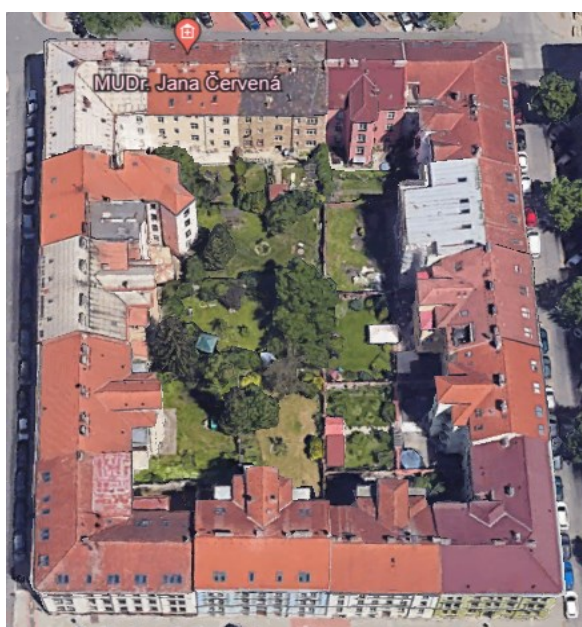
Obrázek 23: 3D snímek vnitrobloku J z roku 2024
