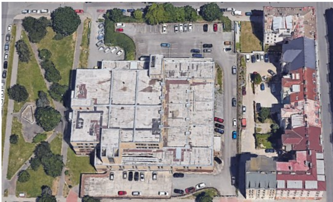
Obrázek 15: 3D snímek vnitrobloku CH z roku 2024
