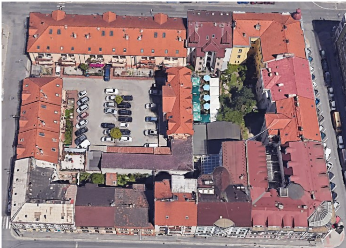
Obrázek 9: 3D snímek vnitrobloku B z roku 2024
