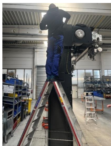
Obrázek 52 – Protahování kabelů k rozvaděči
