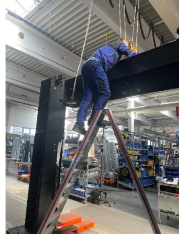
Obrázek 50 – Demontáž oka pro jeřáb
