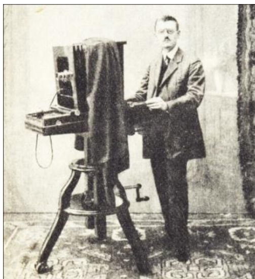
Obrázek 31: Fotograf se svým fotoaparátem na mobilním stojanu s výškovou nastavitelností. [81]
