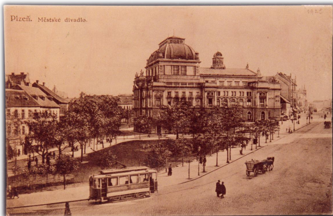
Obr. 2 – Budova Divadla J. K. Tyla v Plzni z roku 1902 – dobová pohlednice
