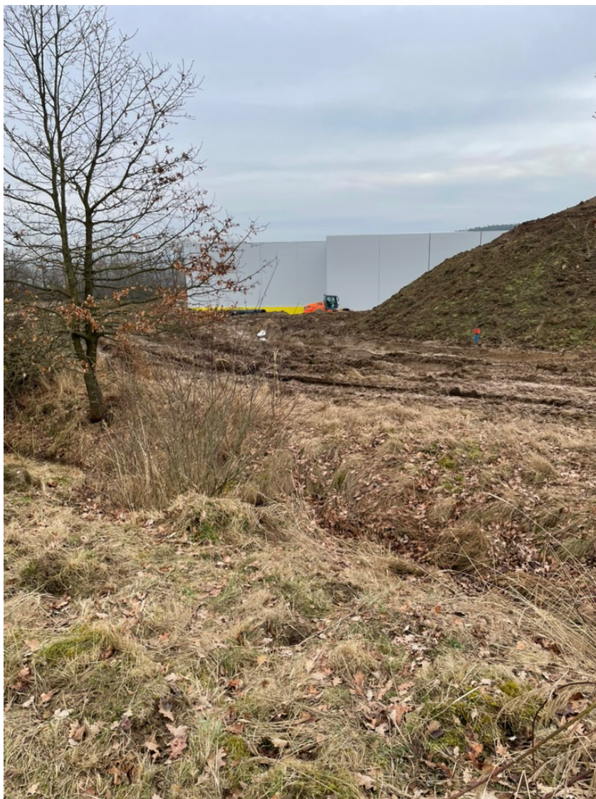
Obr. 1 Budování nového skladovacího komplexu.
