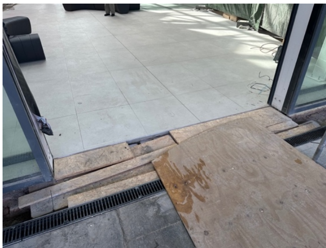
Obrázek 11: Výškové rozdíly v místě prahu
