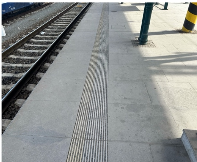
Obrázek 12: Nedostatečný vizuální kontrast vodící linie s funkcí varovného pásu
