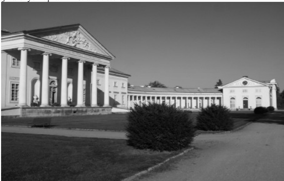
Obr. 2: Běloušský zámek Kačina je svou délkou 227 m největší stavbou českého empiru a přirozenou dominantou krajiny
