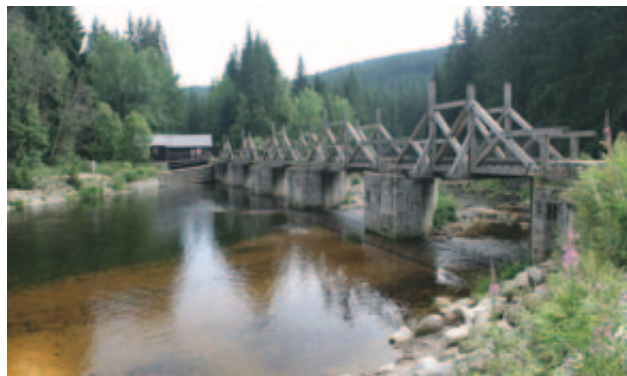
Obrázek 4. Rekonstrukce hradlového mostu, tzv. rechlí, se vtokovým objektem na začátku kanálu.
